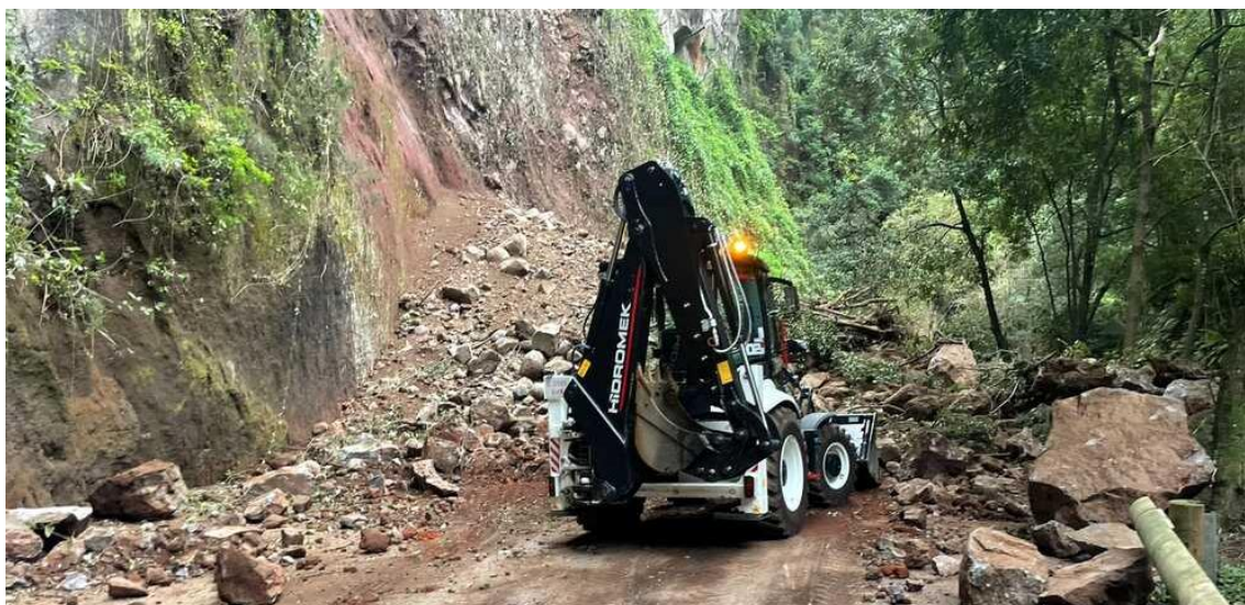
Figura 16. La Provincia (2023). Derrumbe en la carretera de acceso a Los Tilos el 6 de diciembre de 2023. [Fotografía]. Recuperado de: https://www.laprovincia.es/videos/gran-canaria/2023/12/06/importante-derrumbe-carretera-tilos-moya-95533749.html
