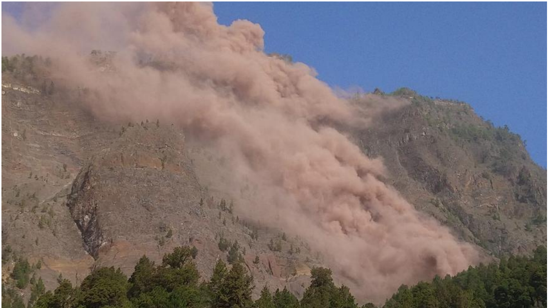
Figura 12. El Time (2020). Importante desprendimiento en la Caldera de Taburiente el 23 de Febrero de 2020. [Fotografía]. Recuperado de: https://www.etime.es/isla-bonita/25620-impresionante-desprendimiento-en-la-caldera-de-taburiente.html
