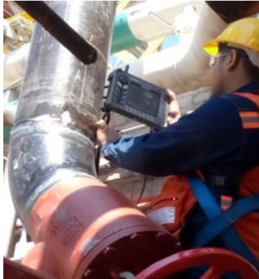
Figura 37: Inspección boroscópica en una tubería (EDEMAQ)
