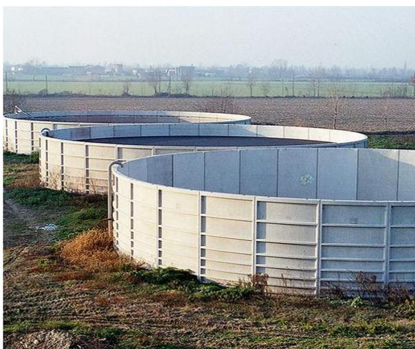
**Figura 10: Tanque prefabricado de hormigón armado para almacenamiento de agua (PAVER)**
