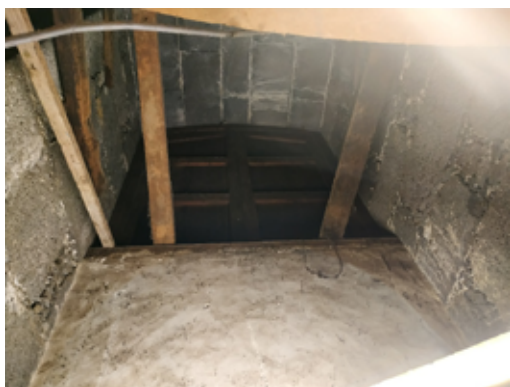
Fig. 10. Detalle de uno de los huecos interiores en la pared de la capilla, oculto tras el retablo.
