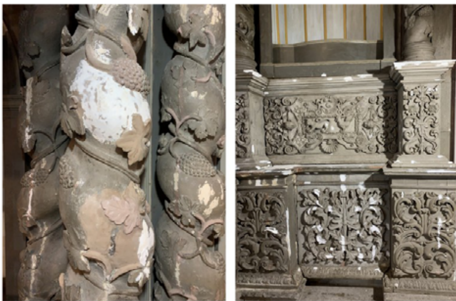
Fig. 3. Detalles de las columnas y el sotabanco durante la restauración.
