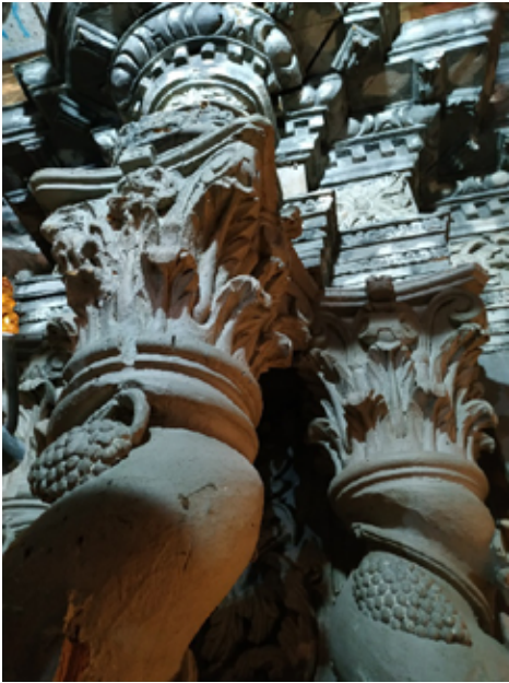
Fig. 20. Detalle de los capiteles y columnas del retablo del Señor Preso durante su restauración.
