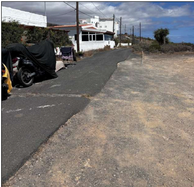
Imagen 2. Inicio de pista de tierra del Camino Transversal Las Eritas.
