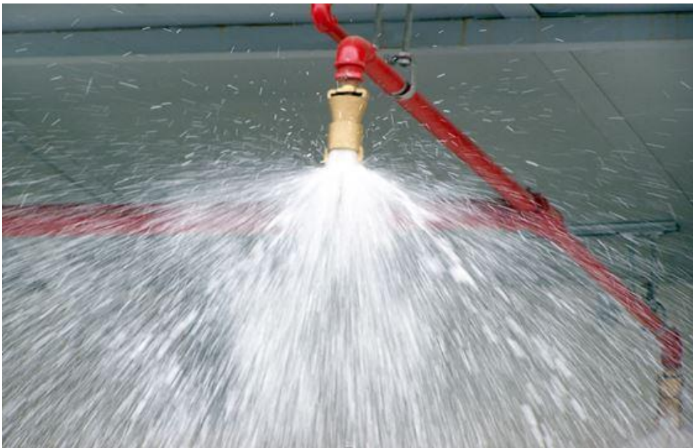
Ilustración 6. Rociador automático o sprinkler. Fuente: prosiseco.com.
