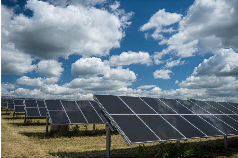
**Figure 25:** Soporte de paneles fotovoltaicos fijos, con una determinada altura sobre el suelo y con cierta inclinación. Imagen extraída de [21].
