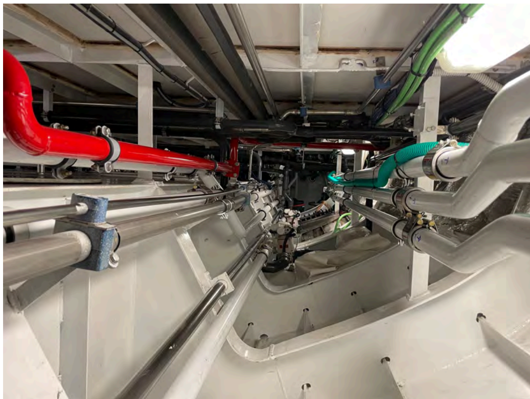
Figura 8: Espacio sentina (Fuente: Trabajo de campo)
