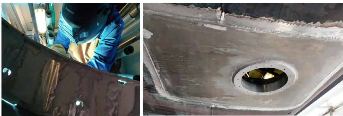
Figura 17: Soldadura plancha principal (Fuente: Trabajo de campo)
