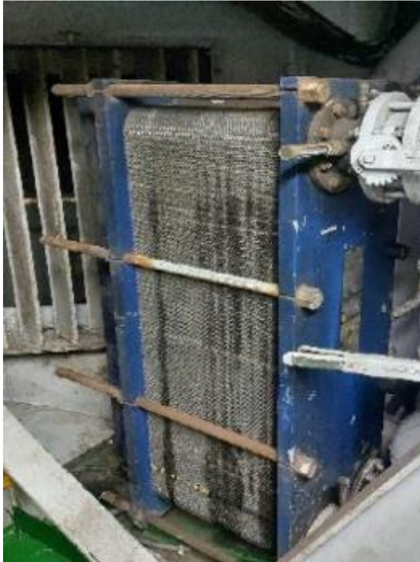
Ilustración 32. Enfriador de Aceite lubricante refrigerado por el sistema de LT. Fuente: Elaboración propia.
