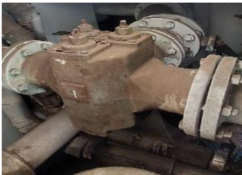
Ilustración 34. Paquete de 3 termostáticas del motor principal. Fuente: Elaboración propia.
