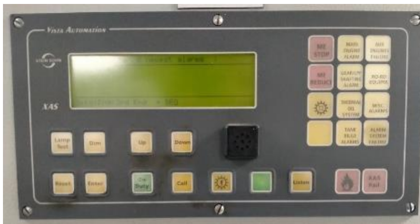
Ilustración 28. Cuadro del control de alarmas de la sala de máquinas. Fuente: Elaboración propia.
