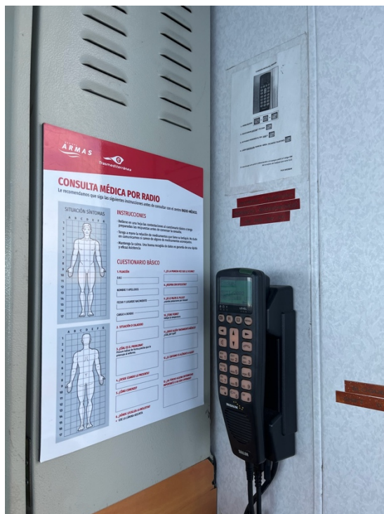
Ilustración 15. Teléfono radio-medico del buque V. Taburiente. Fuente: Trabajo de campo
