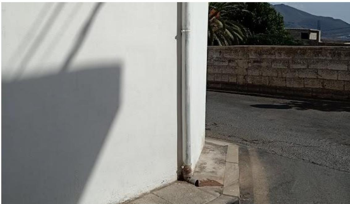
**Imagen 07.** Detalle bajante de Pluviales de viviendas.
