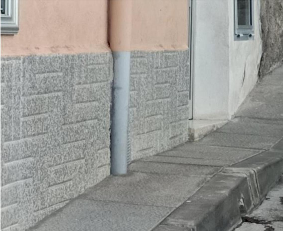
*Imagen 08. Detalle bajante de Pluviales de viviendas.*
