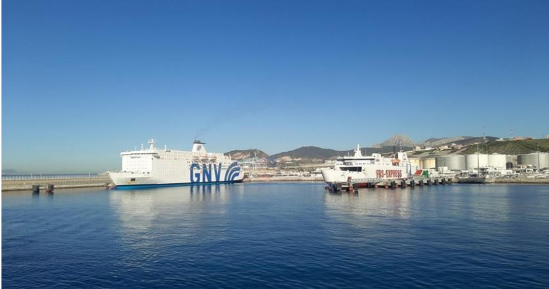
Ilustración 7. Atraques del Puerto de Tánger Med. Fuente: Elaboración propia.
