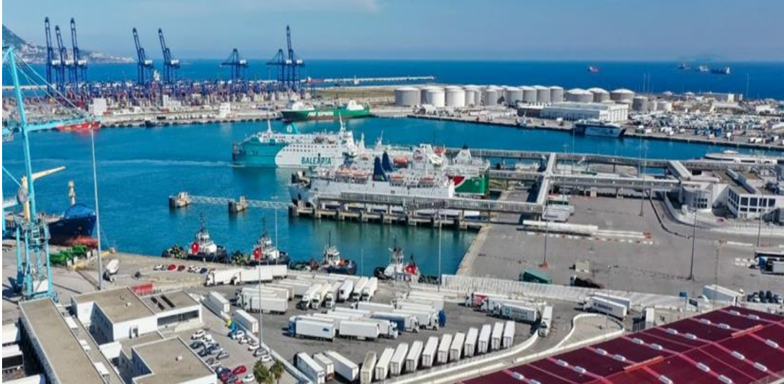
Ilustración 4. Atraques de galera. Fuente: Puertos del Estado (2024).
