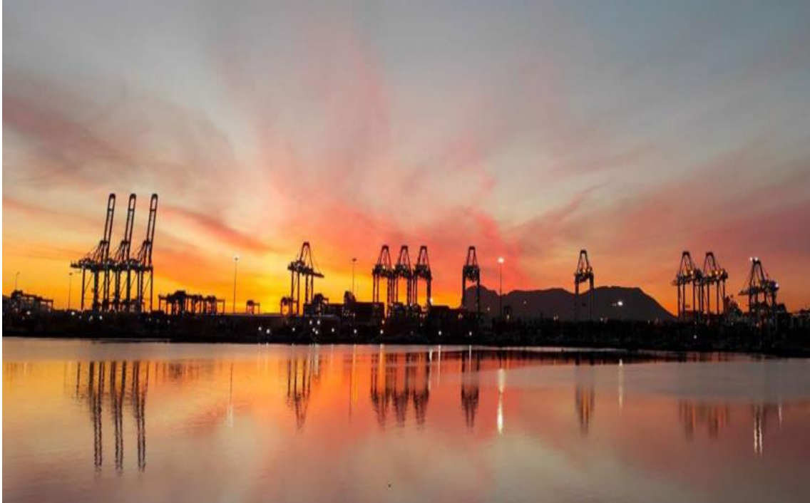
Ilustración 6. Terminal Portacontenedores. Fuente: Elaboración propia.
