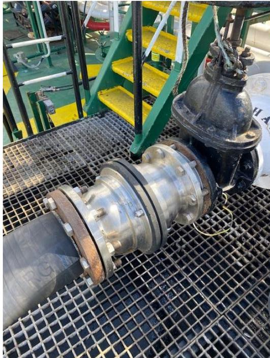
*Ilustración 15. Break Away Coupling System en manifold buque Petromar. Fuente: trabajo de campo.*
