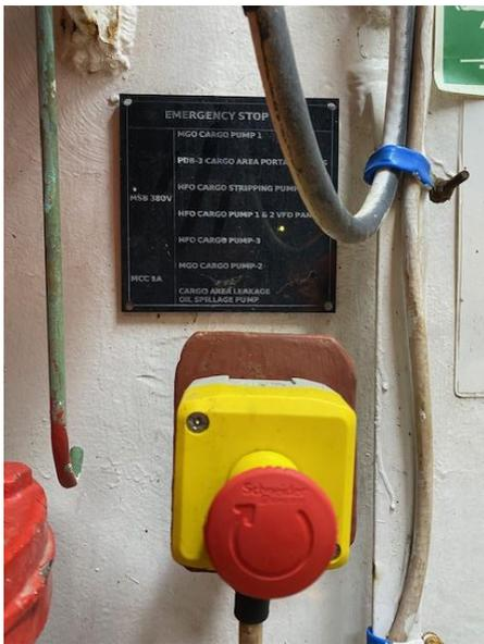
*Ilustración 25. Pulsador parada de emergencia de cubierta. Fuente: trabajo de campo.*
