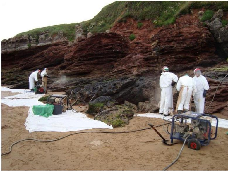
**Ilustración 42.** Limpieza a presión de zona rocosa. Fuente: TRAGSA.
