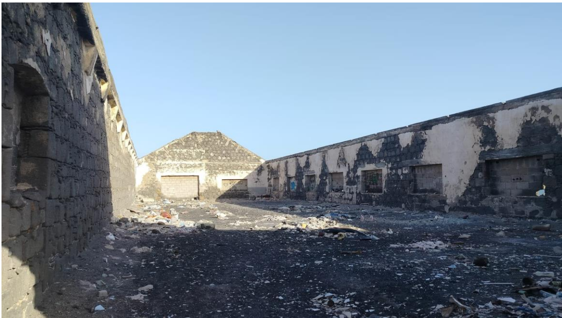
Fig. 2. Interior de la nave principal de la conservera Rocar S.A. Foto del Autor
