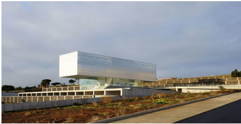
Figura 2.6: Fotografía del edificio del SEGAI.
