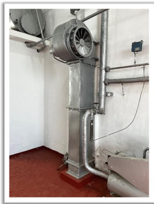
Ilustración 18: Insuflador de aire al quemador (Fondo documental de la Destilería de San Bartolomé de Tejina, S.A.).
