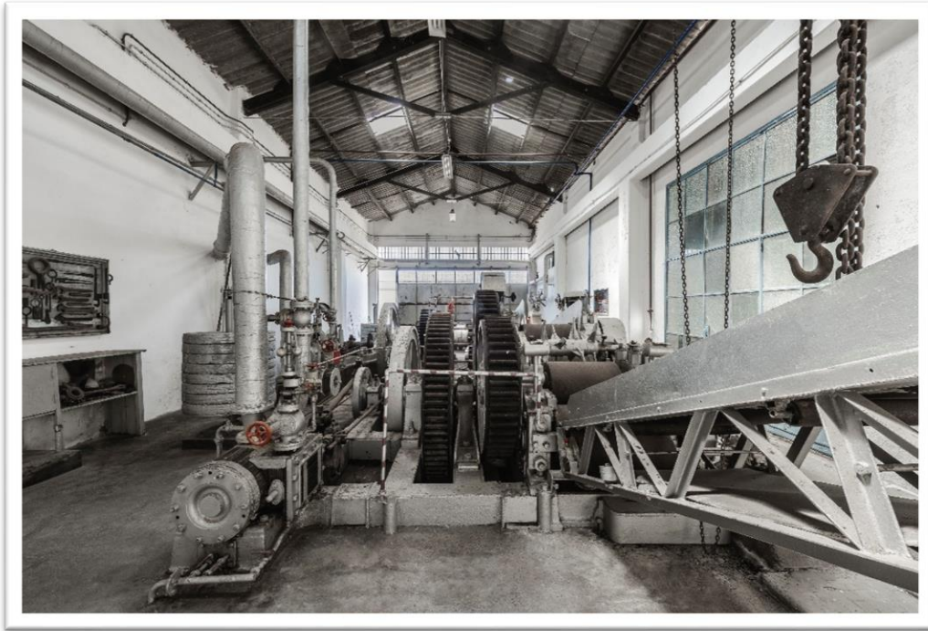
Ilustración 28: Vista general sala de Molturación (Fondo documental de la Destilería de San Bartolomé de Tejina, S.A.).
