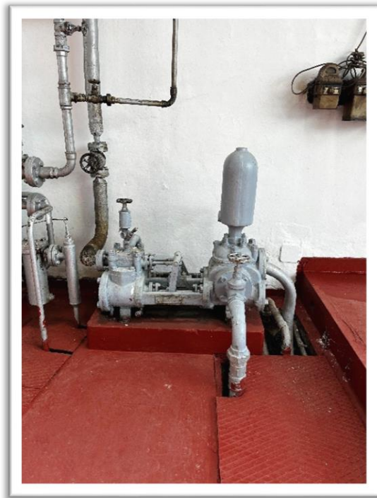
Ilustración 15: Bomba de reserva accionada a vapor (Fondo documental de la Destilería de San Bartolomé de Tejina, S.A.).
