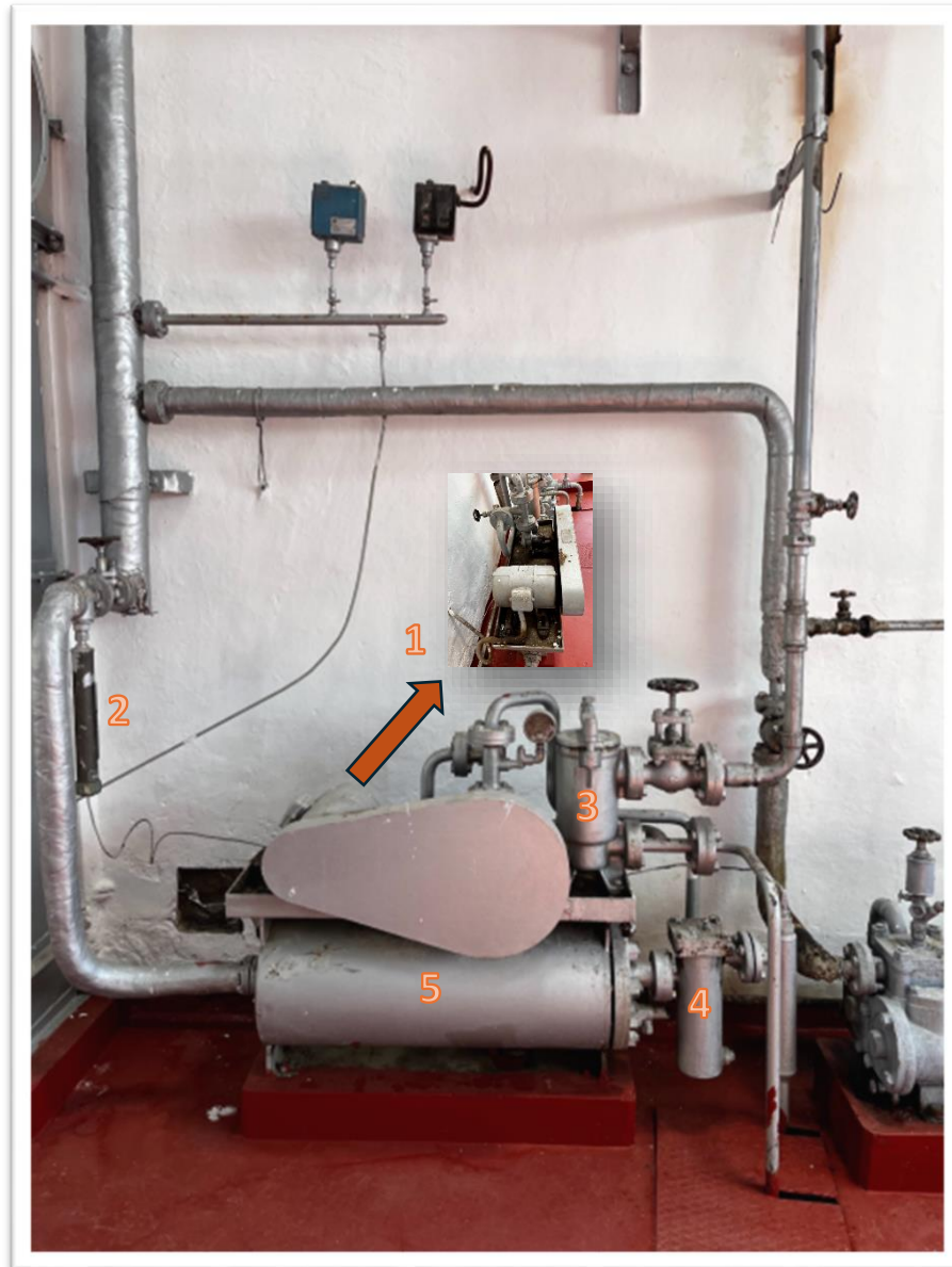
Ilustración 12: Sistema de precalentamiento y alimentación a caldera de combustible (Fondo documental de la Destilería de San Bartolomé de Tejina, S.A.).
