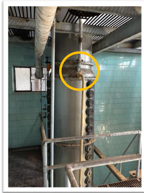
Ilustración 38: Alimentación de la mezcla (mosto) en la columna de destilación (Fondo documental de la Destilería de San Bartolomé de Tejina, S.A.).
