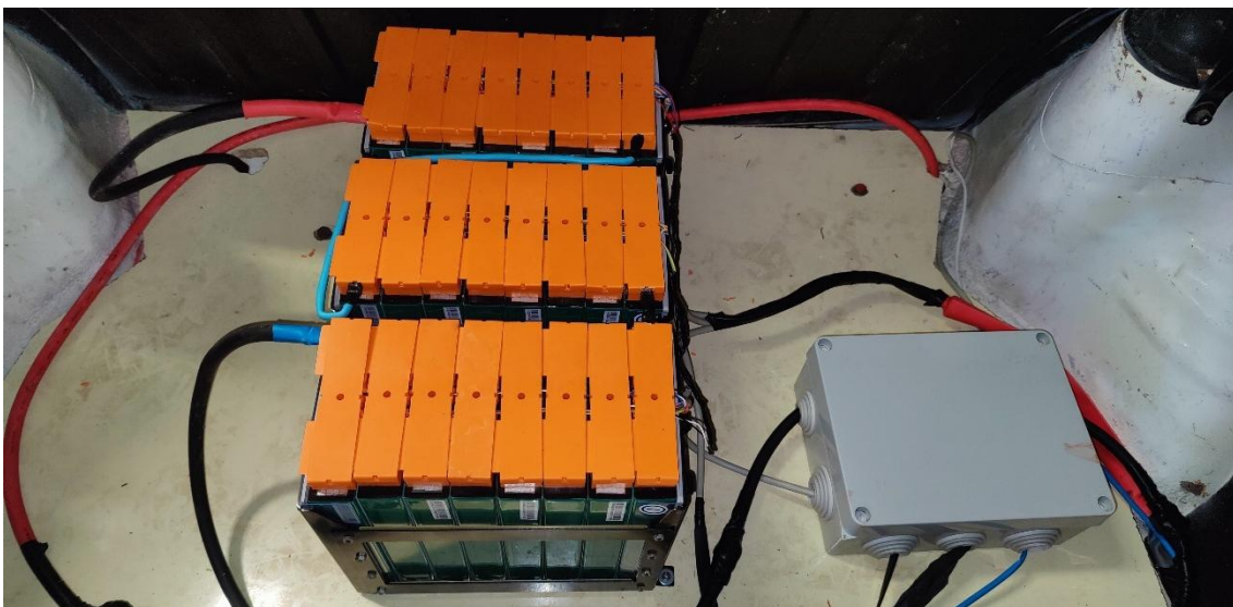
Ilustración 86: Resultado final de la instalación
