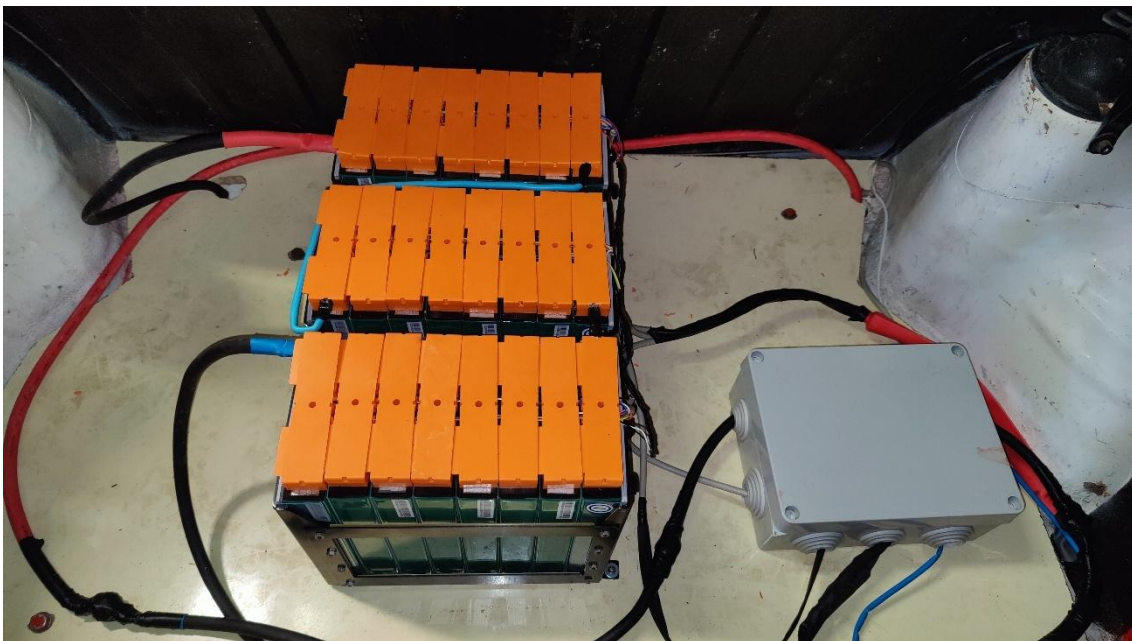
Ilustración 91: Aspecto final de la instalación
