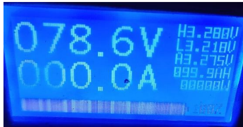
Ilustración 70: Captura de la pantalla en modo voltaje y estado de reserva de batería
