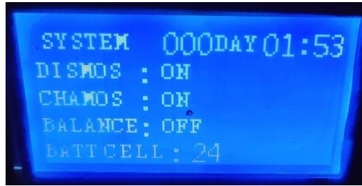
Ilustración 73: Captura de pantalla en modo estado del BMS
