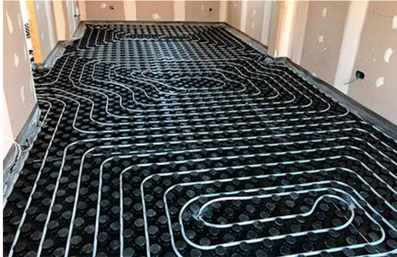
Figura 12 | Instalación de suelo radiante.
