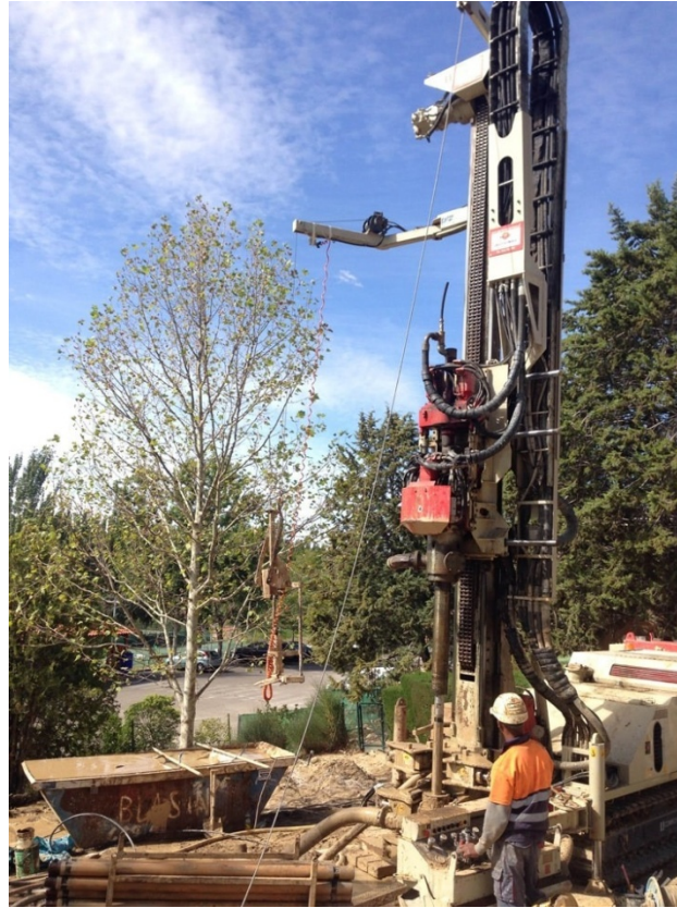
Figura 28 | Equipo de perforación Comacchio MC 900P.
