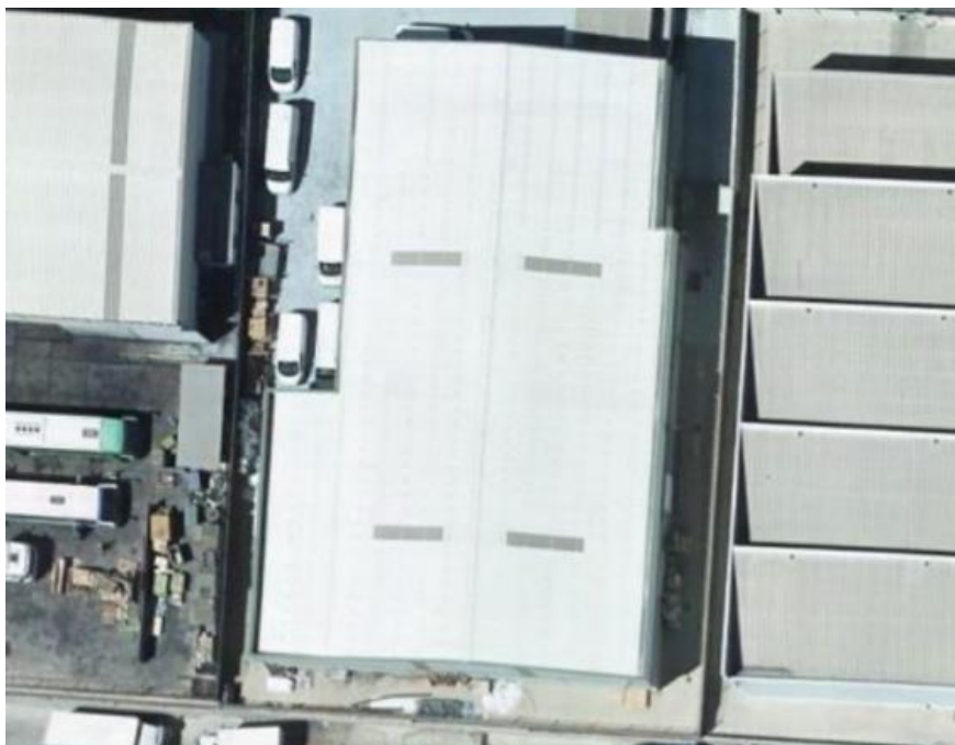
Imagen 2 (Nave industrial a utilizar)
