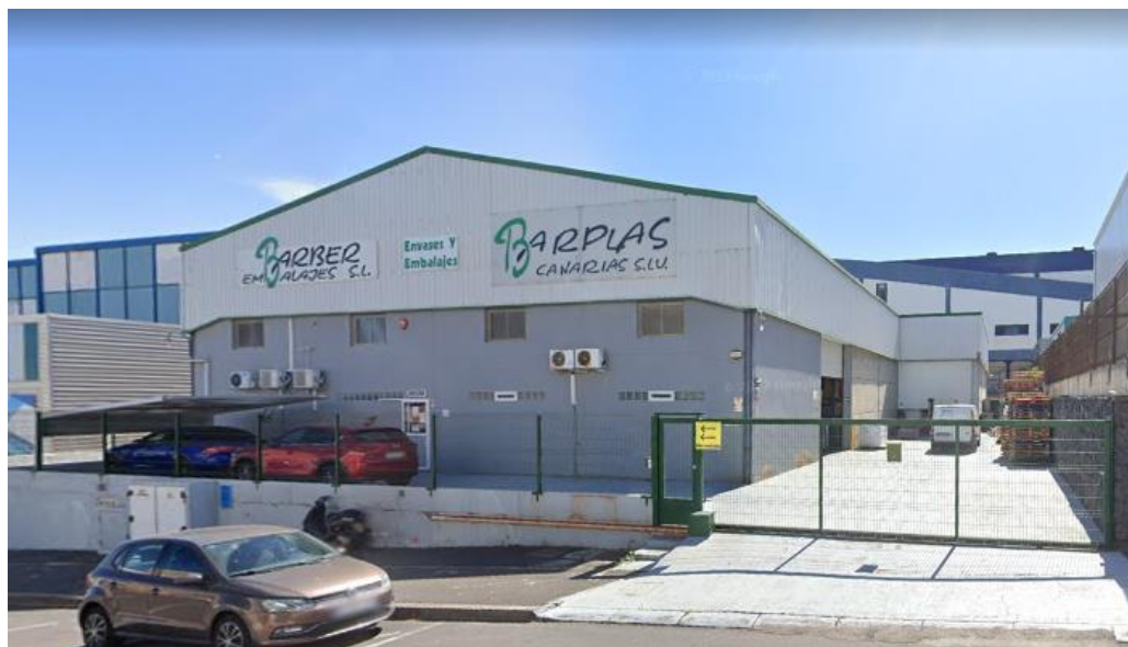
Imagen 17 (Estado actual de la nave)
