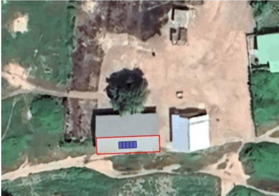
Figura 21. Resultado final de los paneles sobre cubierta.
