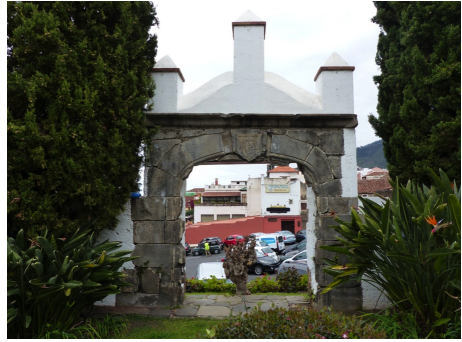
Figura 7.- Portada de la cochera de la casa Franchi tras su nuevo emplazamiento.
