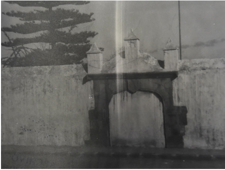
Figura 6.- Portada de la cochera de la casa Franchi antes de su desmonte y traslado.
