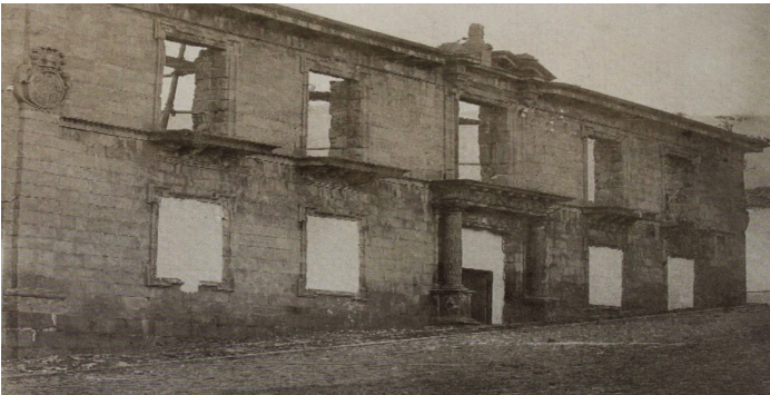
Figura 8.- Fachada desaparecida de la antigua Casa del Marqués de Celada.
