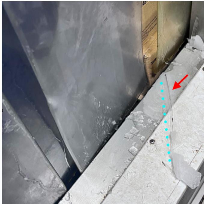
**Figura 4.13:** Hielo por la introducción de humedad
