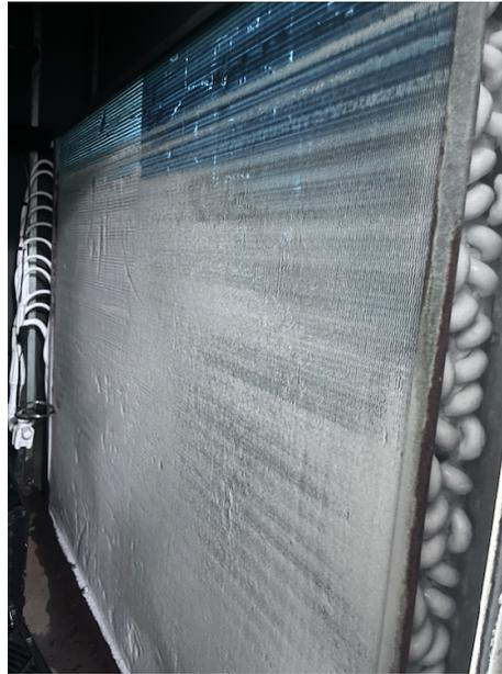
**Figura 4.3:** Evaporador y Válvula de expansión termostática congelados
