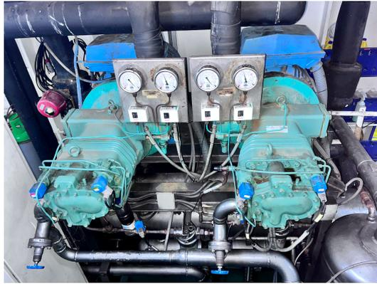
**Figura 3.6:** Compresores de aire acondicionado de pasaje
