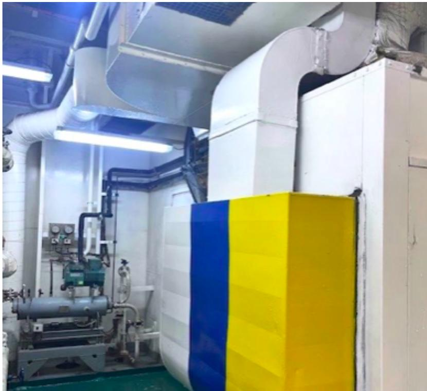
**Figura A.5:** Grupo de frío de aire acondicionado del control
