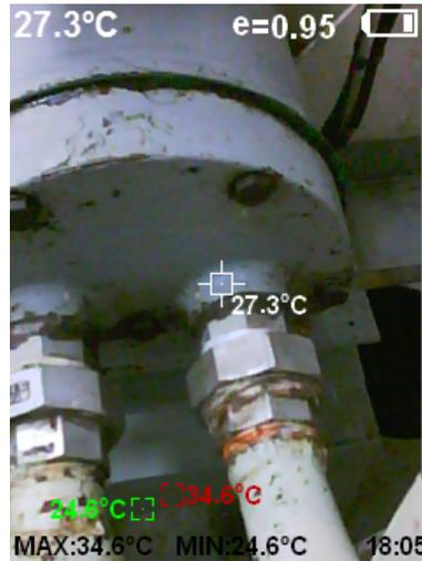
**Figura 4.12:** Temperaturas normales de funcionamiento
