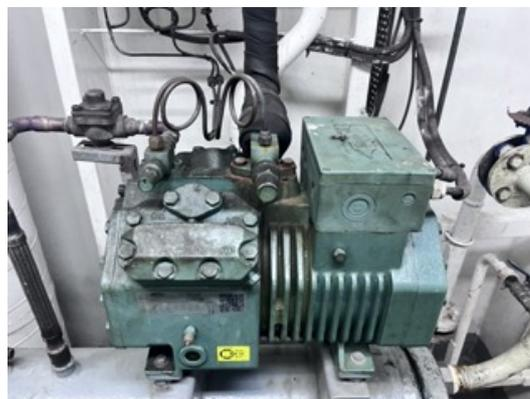
**Figura 3.5:** Compresor de aire acondicionado del control
