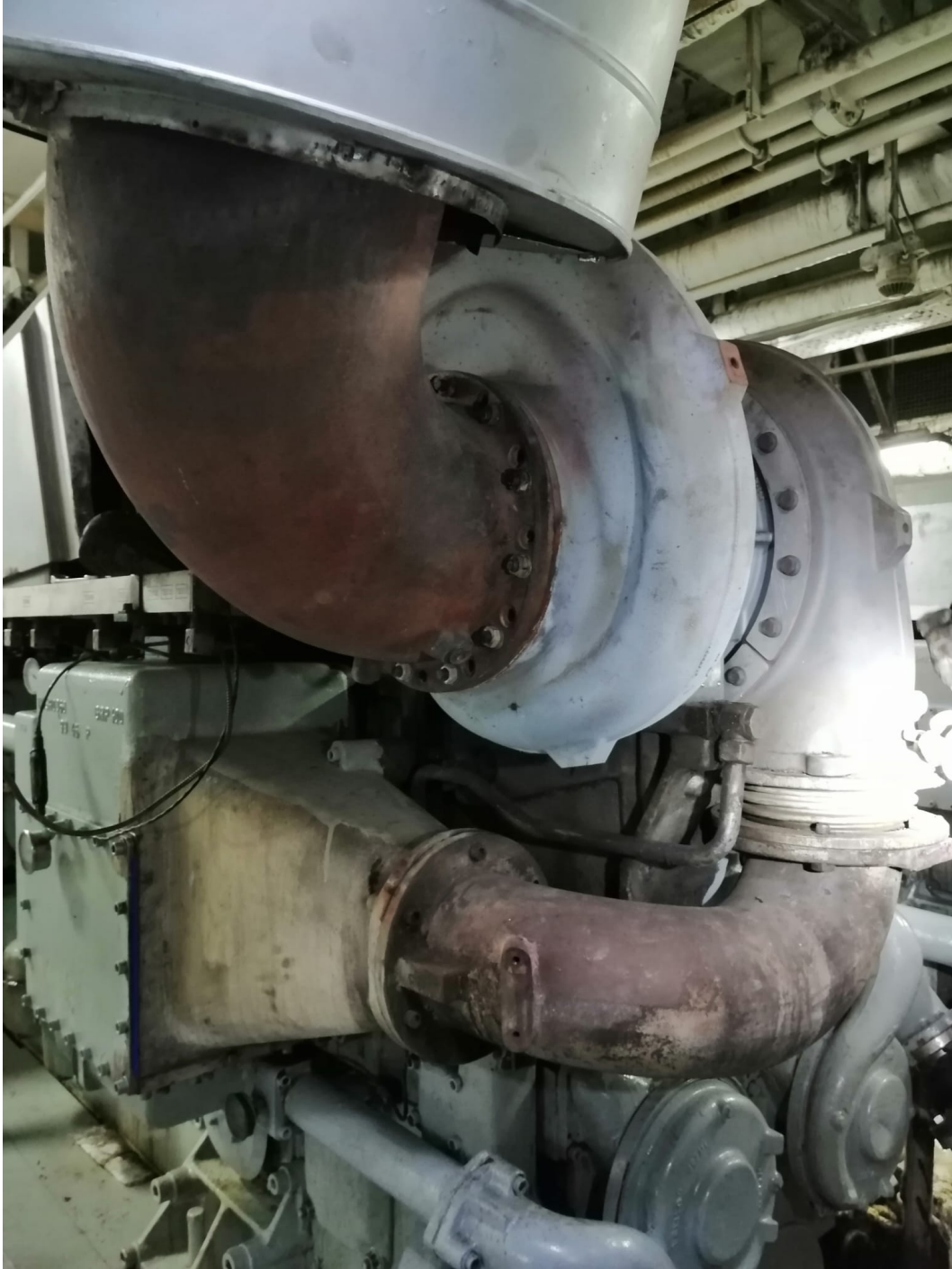
Figura A.5: Motor con la turbo dañada Fuente: Colección propia
