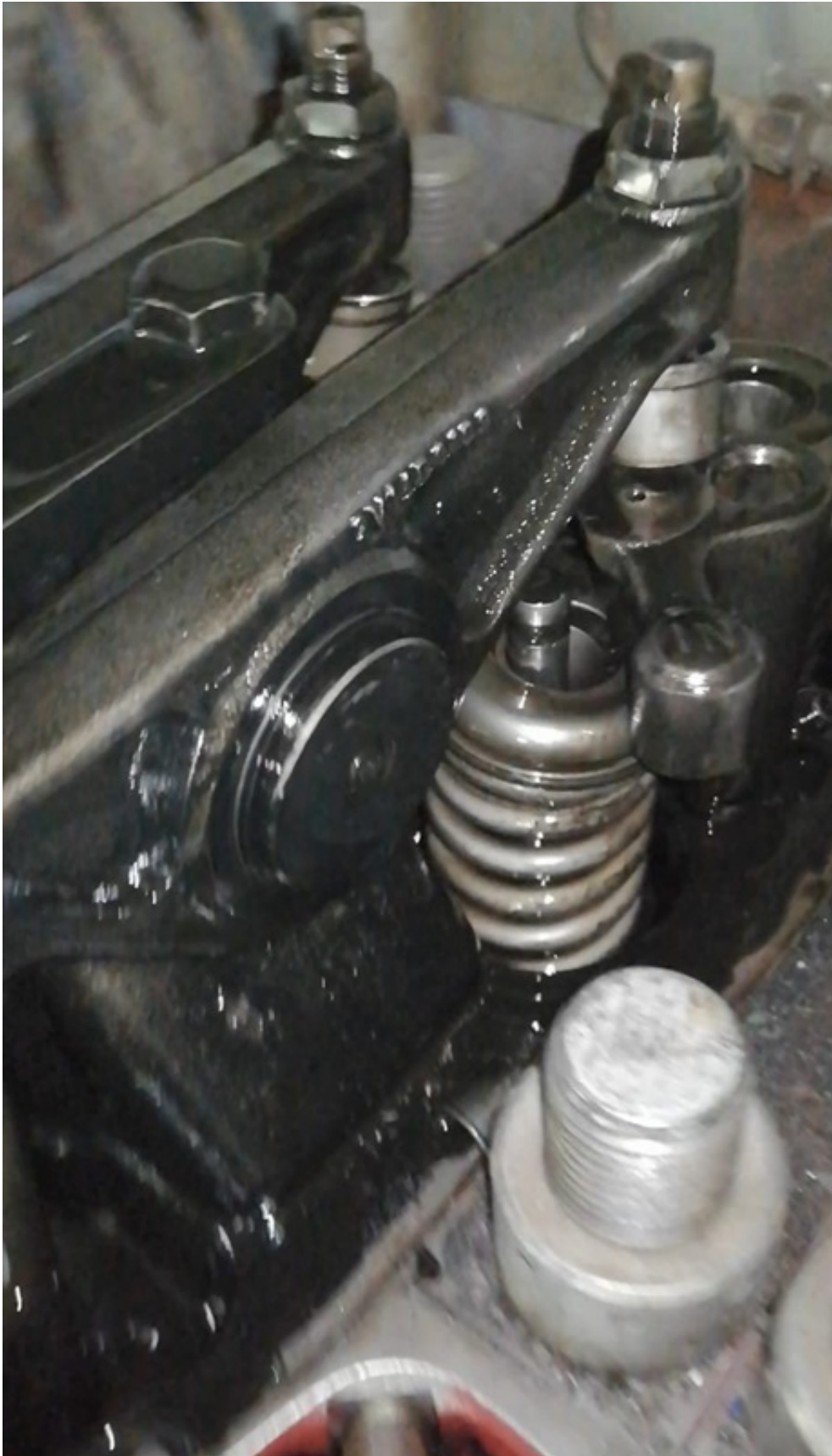
Figura A.3: Daños observados en los balancines de la culata N o 9 del motor auxiliar N o 2
