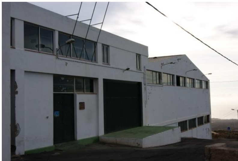
Figura 1: Fachada del Antiguo Empaquetado de Chimiche
