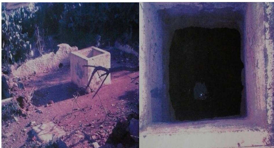
Figura N° 11. Vista de un aljibe (exterior e interior).
