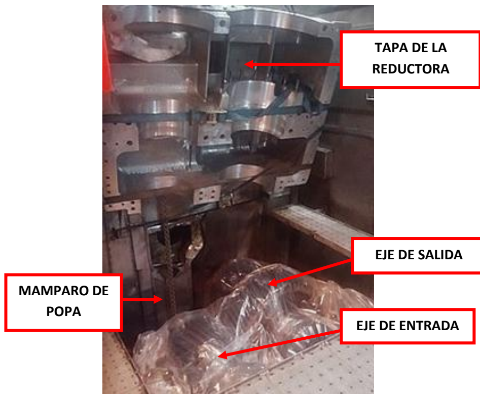
Ilustración nº66. Izado de la tapa de la reductora
