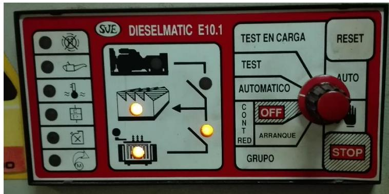
Ilustración 72. Selector modo automático del generador de emergencia. Fuente: Propia.
