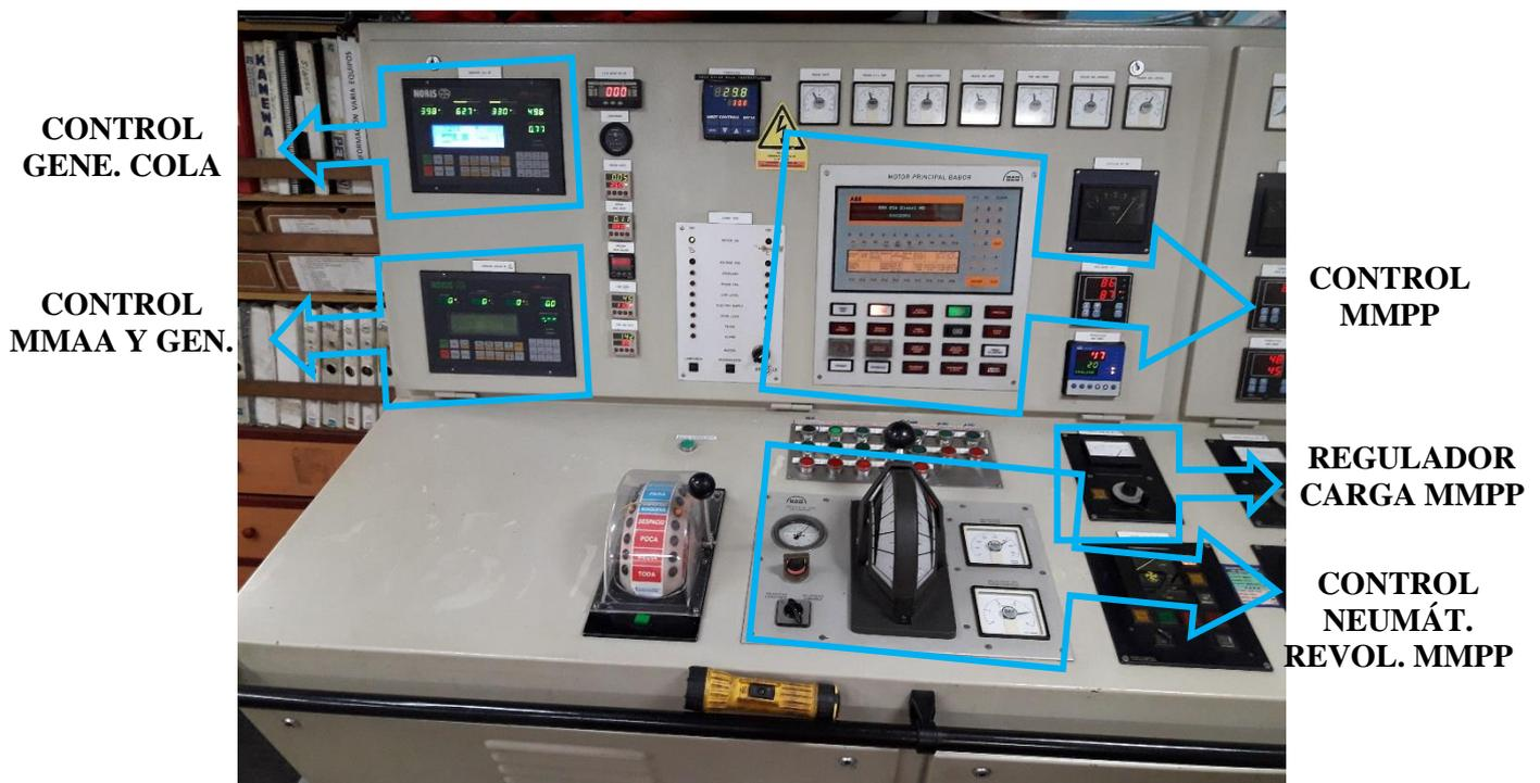
Ilustración 31. Cuadro de control de equipos de propulsión. Fuente: propia.
