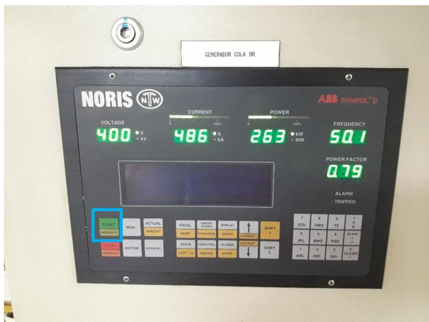
Ilustración 52. Controlador de los generadores auxiliares ABB. Fuente: Propia.
