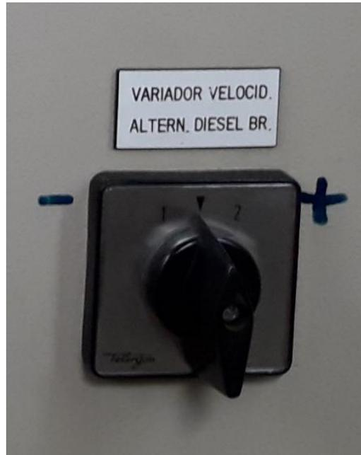
Ilustración 63. Variador de velocidad del alternador de babor. Fuente: Propia.
