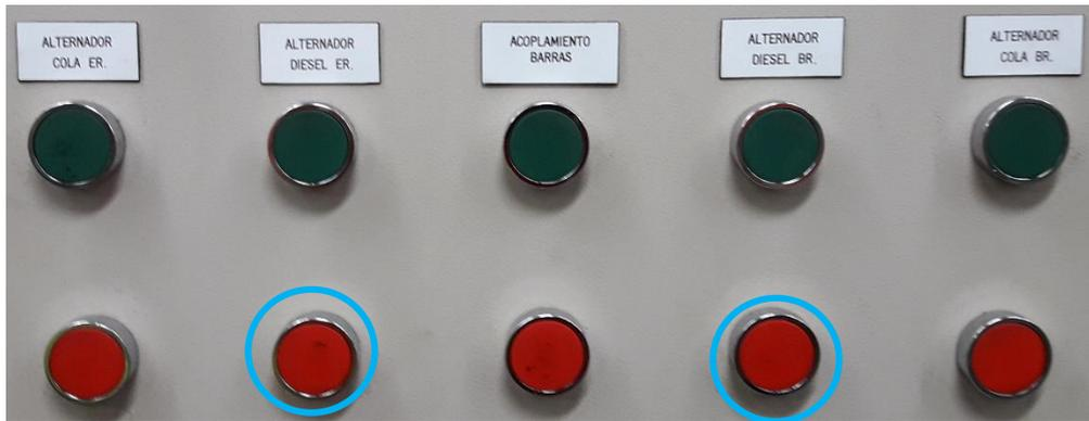
Ilustración 77. Pulsadores de conexión/desconexión. Fuente: Propia
