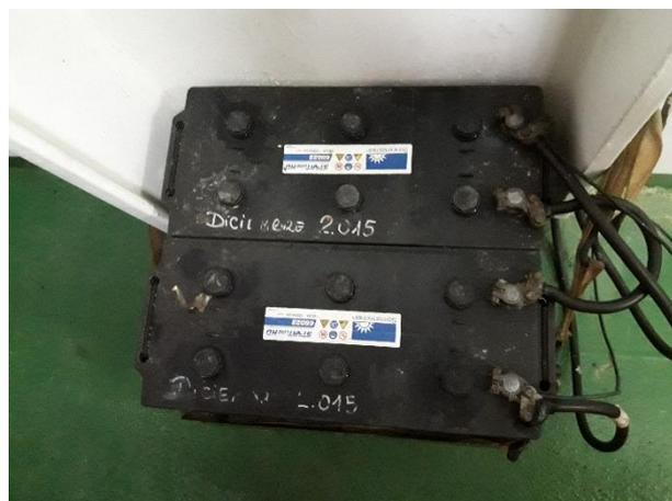
Ilustración 42 y 43. Cargador y baterías del motor de emergencia. Fuente: Propia.
