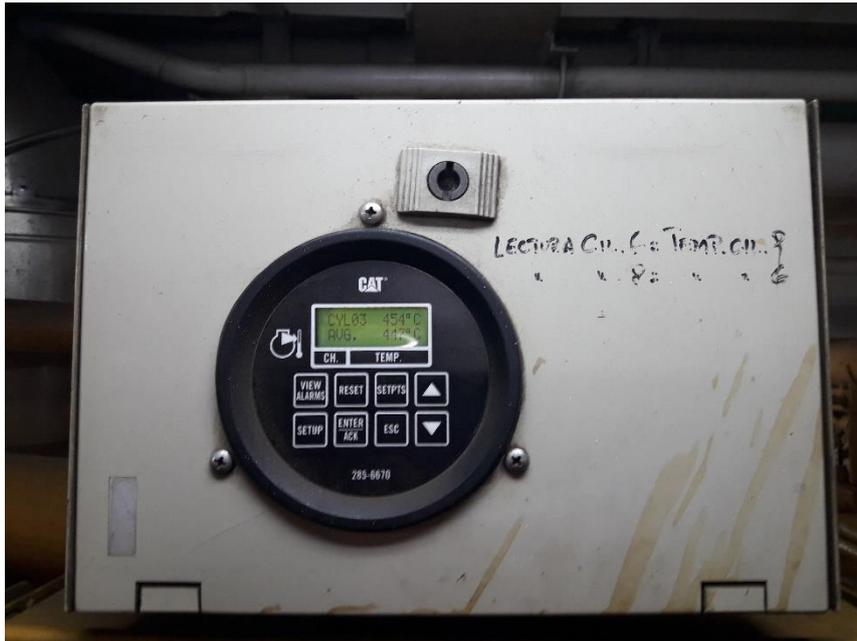
Ilustración 37. Display superior de temperaturas de los MMAA. Fuente: propia
