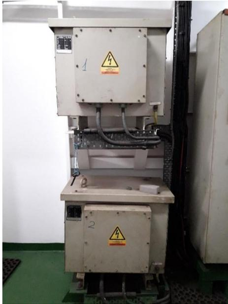
Ilustración 44. Transformadores de emergencia. Fuente: Propia.
