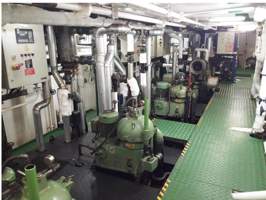
Ilustración 14. Sala de depuradoras y módulo de combustible. Fuente: [2].
