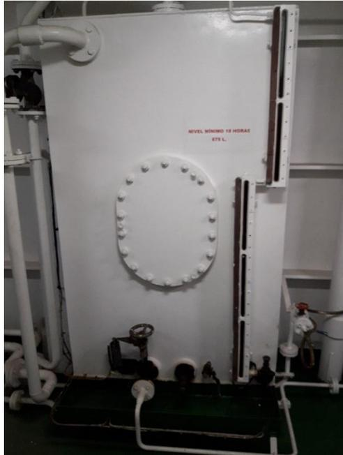
Ilustración 41. Tanque almacén fueloil marino del motor de emergencia. Fuente: Propia.
