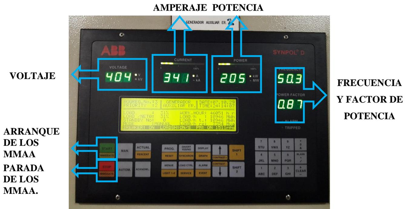
Ilustración 39. Controlador ABB para los auxiliares. Fuente: Propia.
