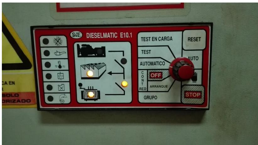
Ilustración 48. Selector de arranque del motor de emergencia. Fuente: Propia.
