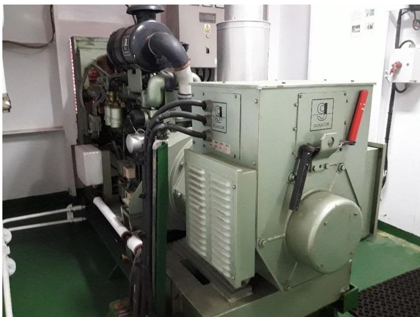
Ilustración 15. Motor de Emergencia. Fuente: [2].
