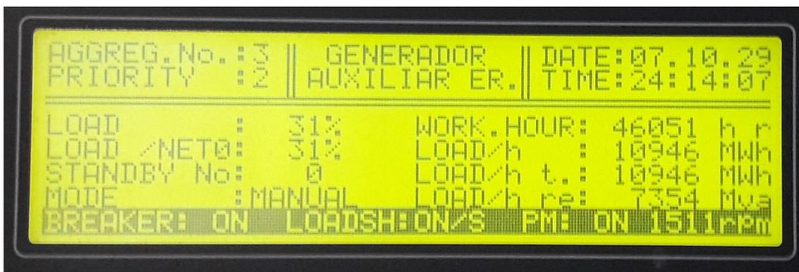
Ilustración 53. Display del controlador ABB. Fuente: Propia.
