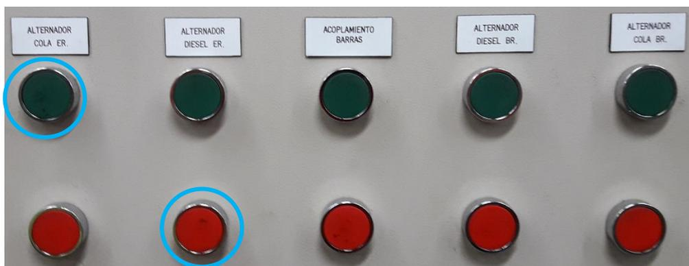
Ilustración 68. Botonera de conexión. Fuente: Propia.
