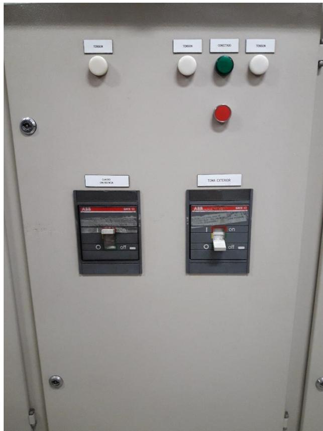
Ilustración 73. Machete de conexión del generador de emergencia. Fuente: Propia.
