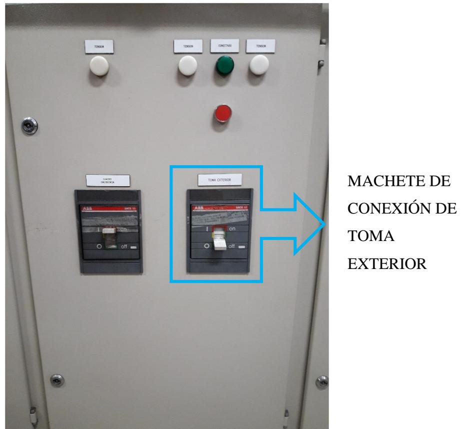
Ilustración 79. Consola del motor de emergencia. Fuente: Propia
