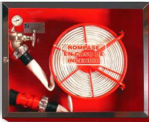
Ilustración 26 Boca de Incendio Equipada
