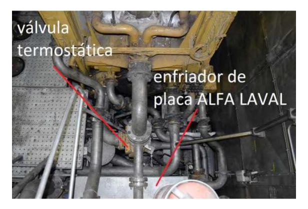
Ilustración nº 31: Válvula termostática de aceite y Enfriador de Placas (Alfa Laval). Fuente: Trabajo de Campo.[9]
