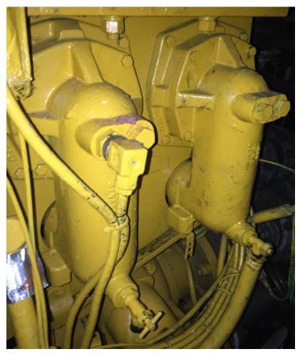
Ilustración nº 33: Columnas Filtros (Vokes Simplex). Fuente: Trabajo de Campo.[9]
