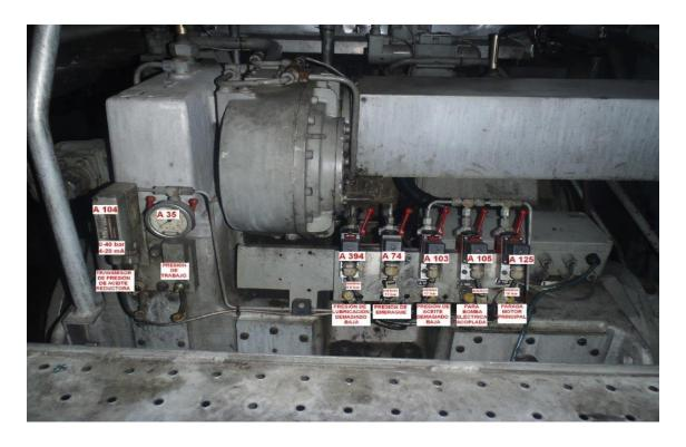
Ilustración nº 43: Presostatos Reintjes VLJ 6831 Fuente: Trabajo de Campo.[9]
