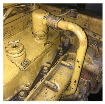
Ilustración nº 40: Venteo de aceite MM.AA. Fuente: Trabajo de Campo.[9]
