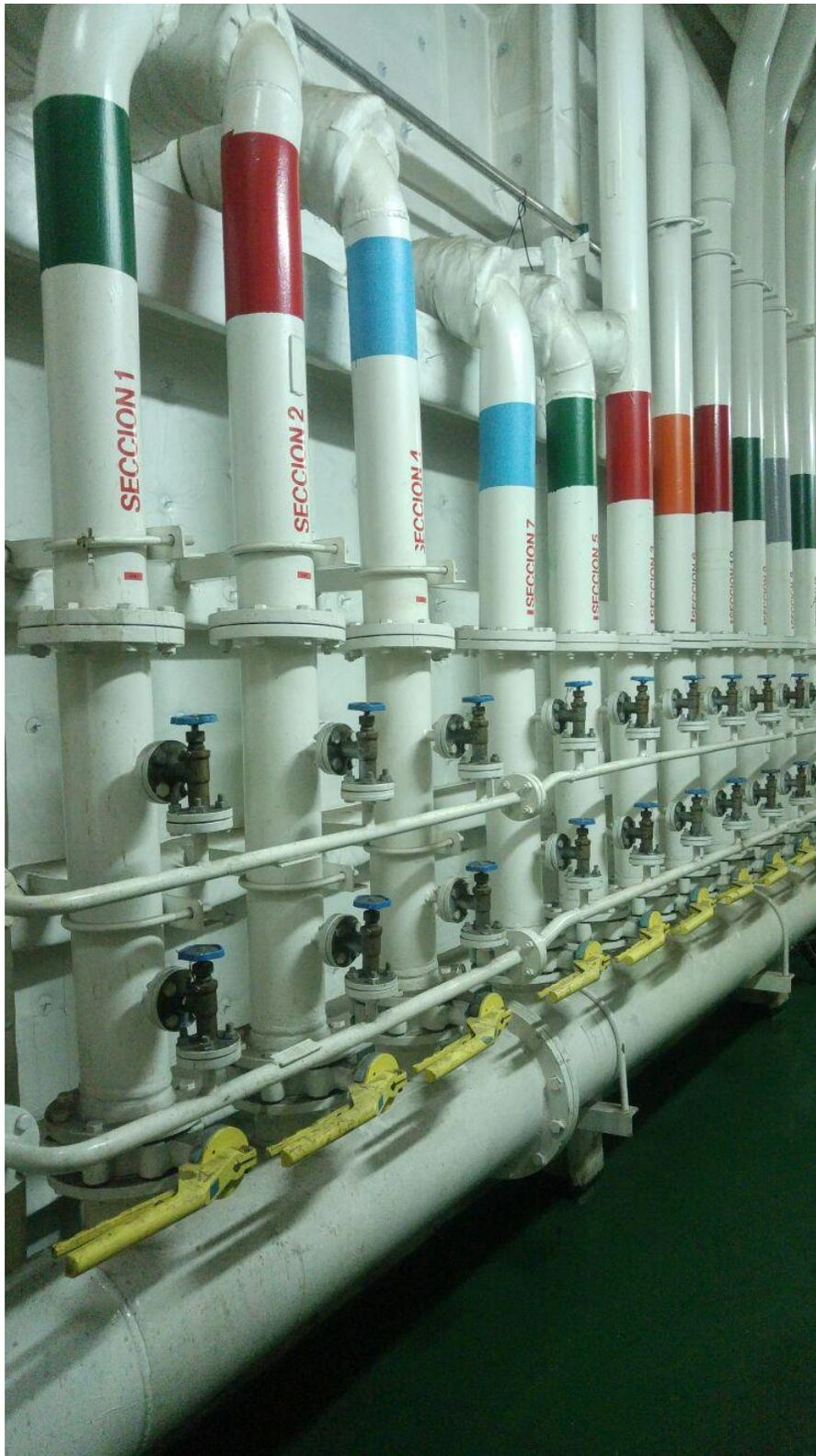
Ilustración 31. Válvulas sistema de rociadores. Fuente: Trabajo de campo
