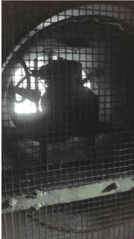
Ilustración 20. Conducto de ventilación y motor del ventilador . Fuente: Trabajo de campo
