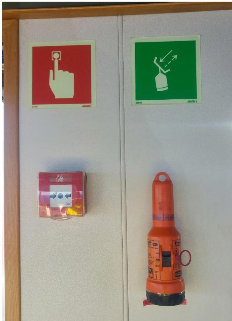
*Ilustración 54. Transponder y pulsador de alarma junto a sus señales. Fuente: Trabajo de campo*
