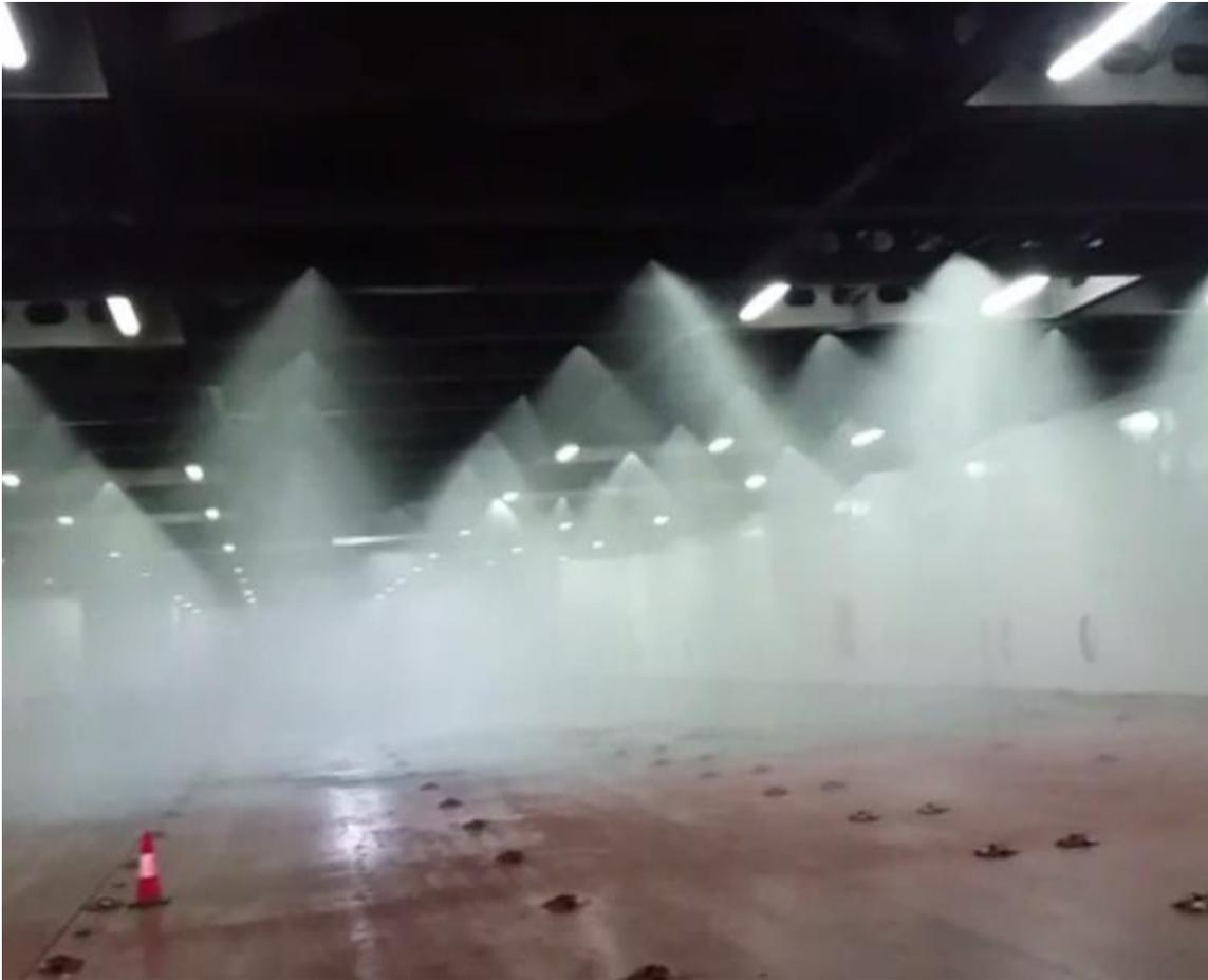
*Ilustración 32. Rociadores en funcionamiento. Fuente: Trabajo de campo*
