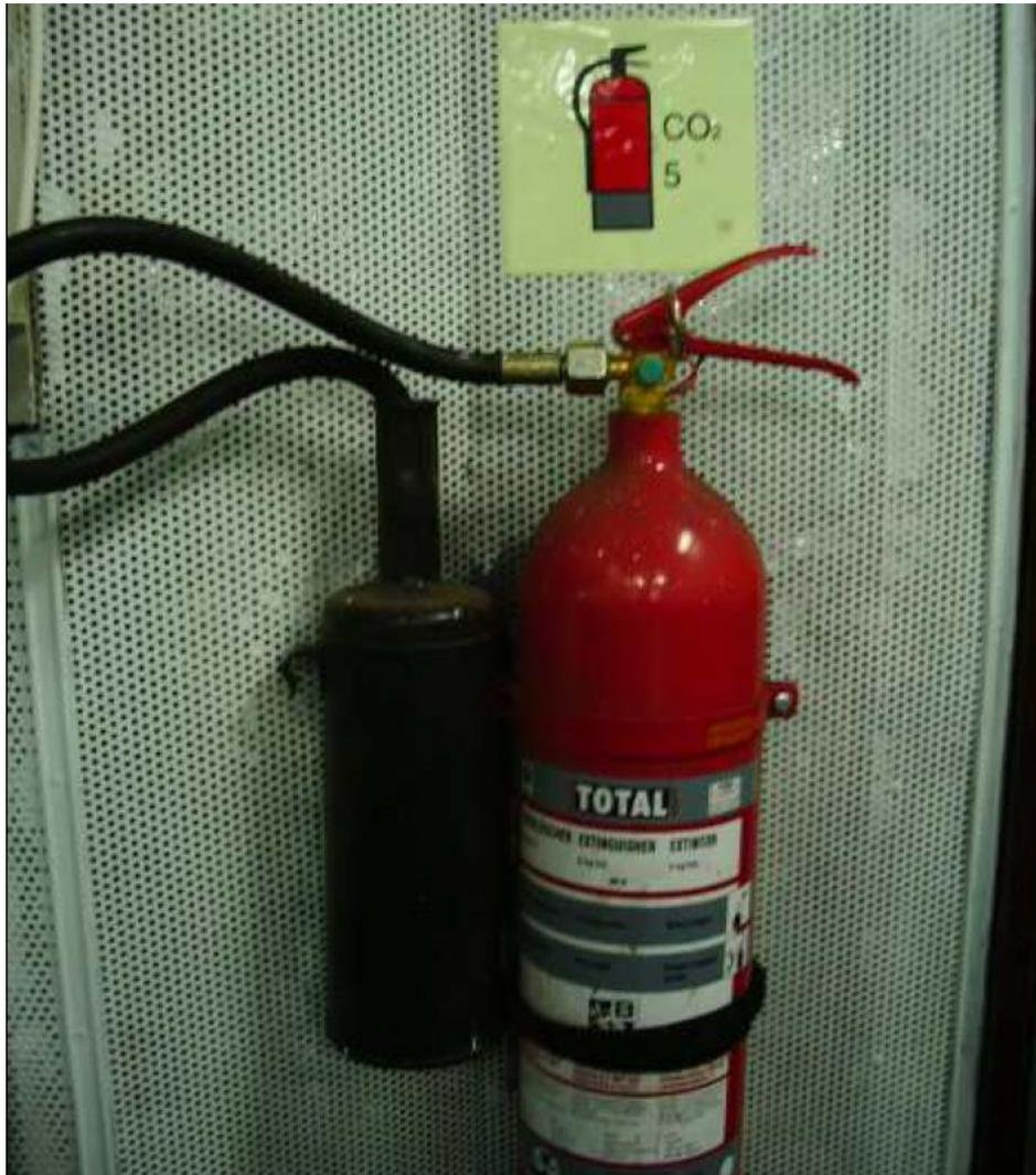
Ilustración 27. Extintor de CO<sub>2</sub>. Fuente: Trabajo de campo
