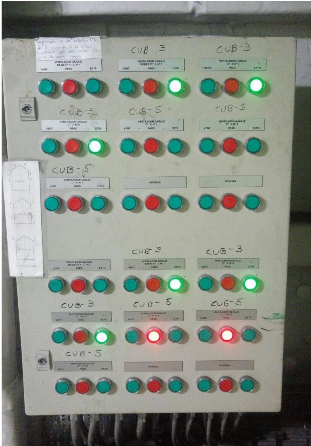
Ilustración 18. Cuadro de ventilaciones situado en el control de carga. Fuente: Trabajo de campo
