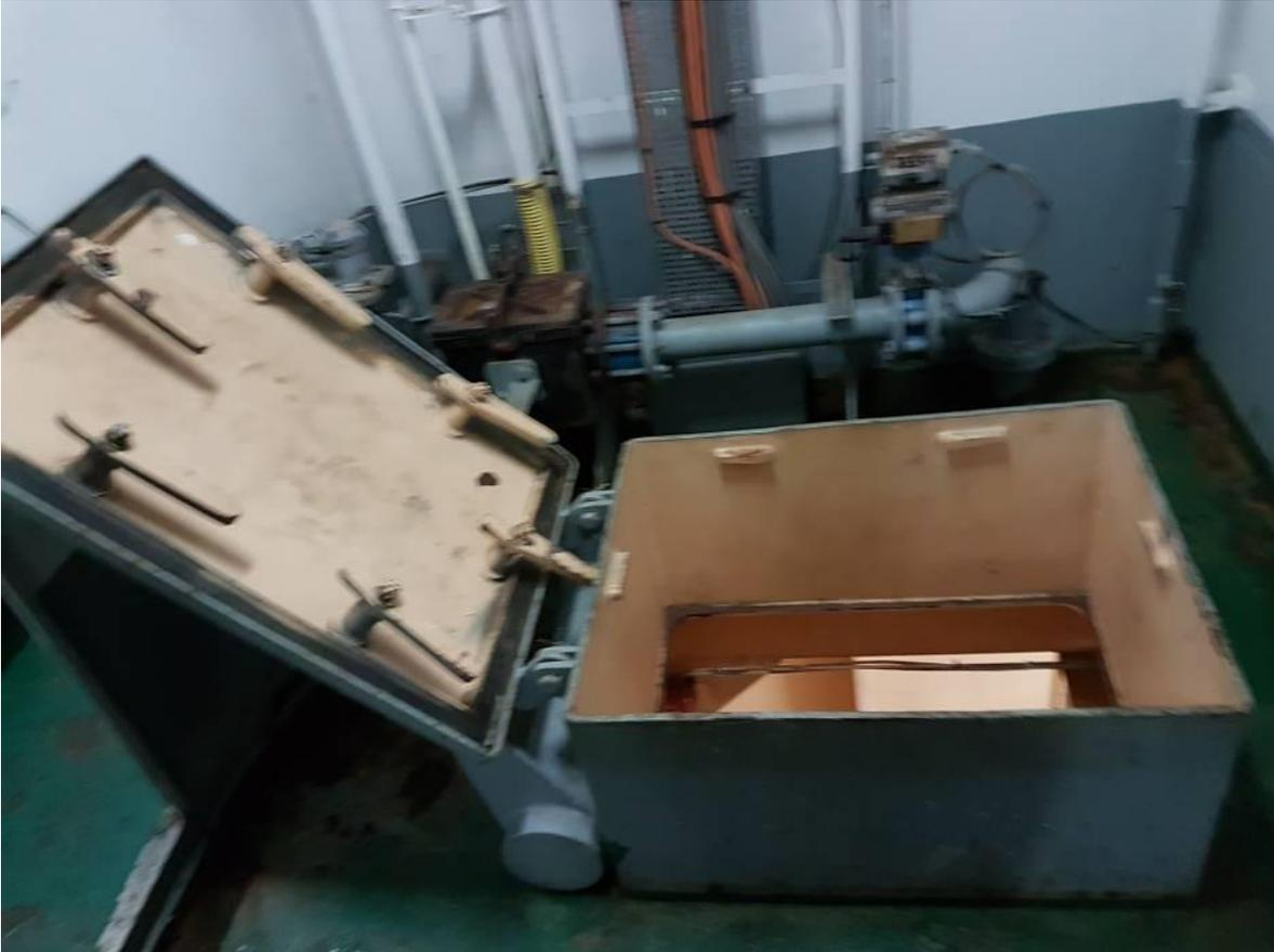
*Ilustración 39. Salida de emergencia del Local de Bombas (el túnel). Fuente: Trabajo de campo*
