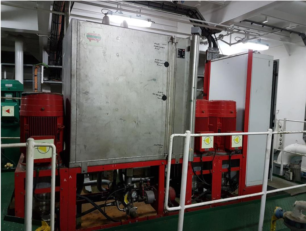
*Ilustración 35. Tanque y bombas sistema sprinklers. Fuente: Trabajo de campo*
