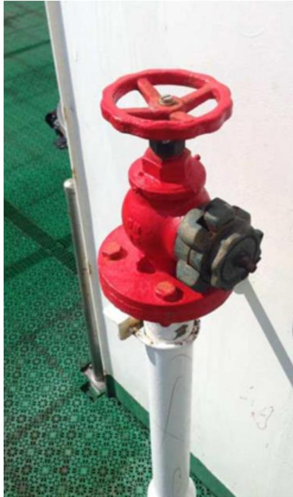
*Ilustración 25. Hidrante. Fuente: Trabajo de campo*
