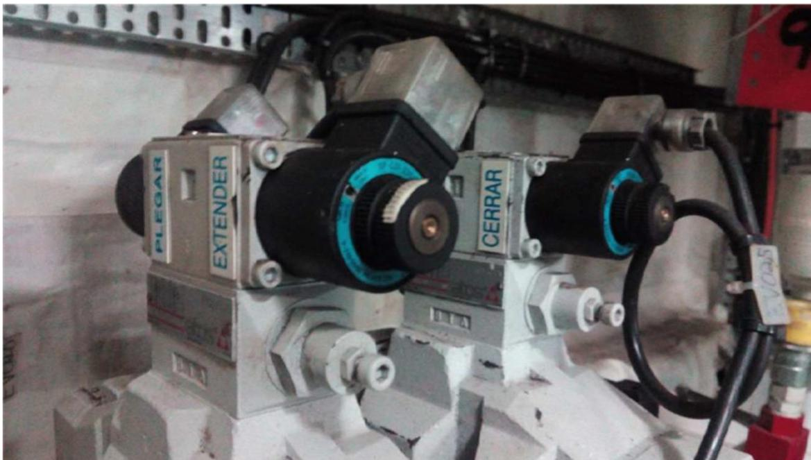
Ilustración 63. Etiquetas relés válvulas hidráulica. Fuente: Trabajo de campo
