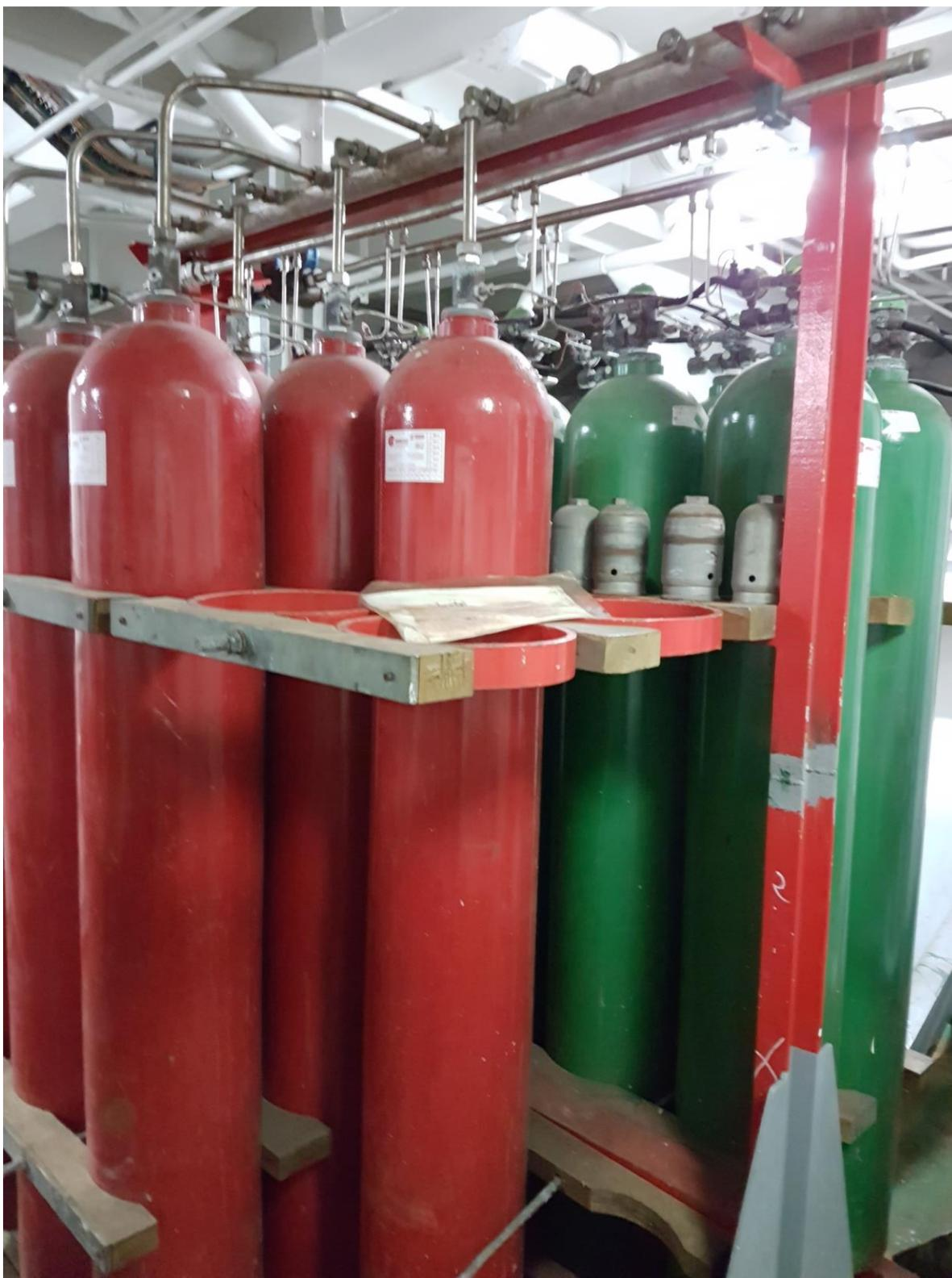
*Ilustración 34. Botellas de nitrógeno y agua para el sistema de sprinklers. Fuente: Trabajo de campo*
