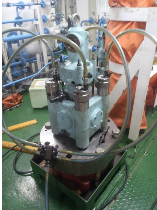
Fig. 100 Gatos hidráulicos montados en la válvula de escape
