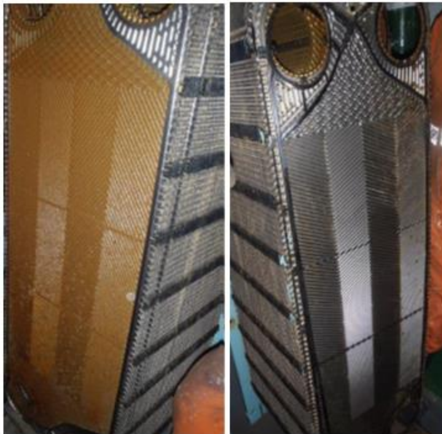
Fig. 62 Placa del enfriador antes y después de ser limpiada
