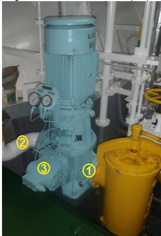
Fig. 53 Bomba aceite de lubricación motor principal
