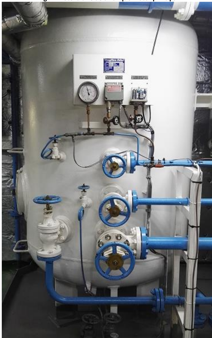
Fig. 12 Botella aire de arranque motor principal
