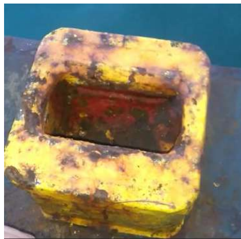
Ilustración 52 Fundamento Elevado Fuente: Trabajo de Campo
