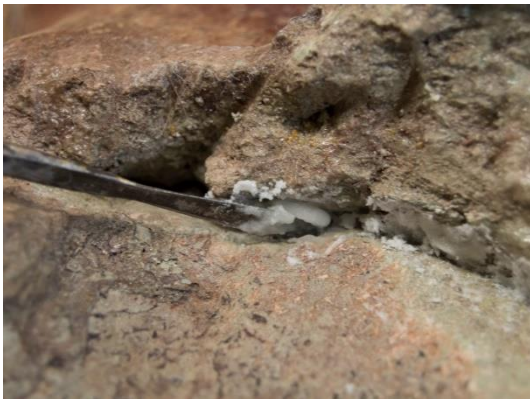
Figura 79. Reintegración de la grieta.
