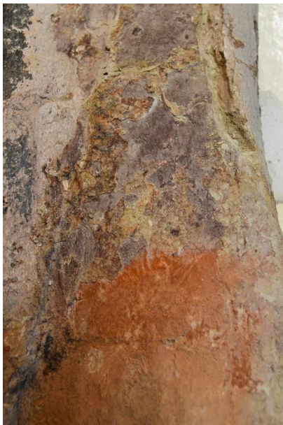
Figura 90. Antes de la restauración.
