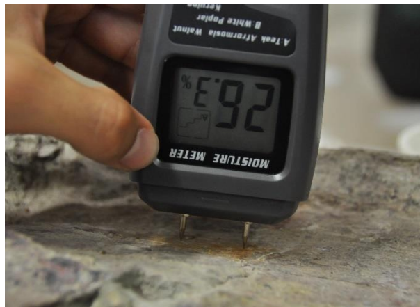
Figura 40. Medición de humedad superficial tras la aplicación de papetas.
