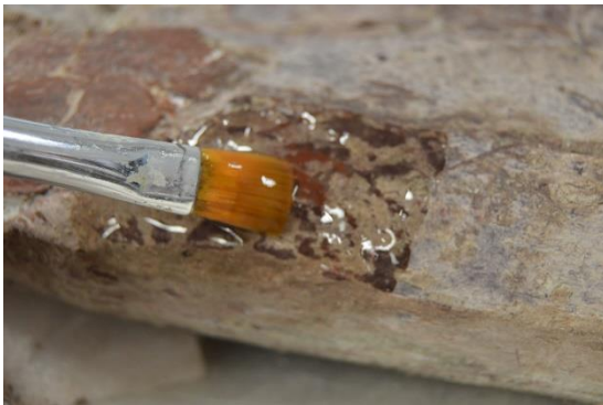
Figura 65. Aplicación de papeta en costra de hierro. Figura
