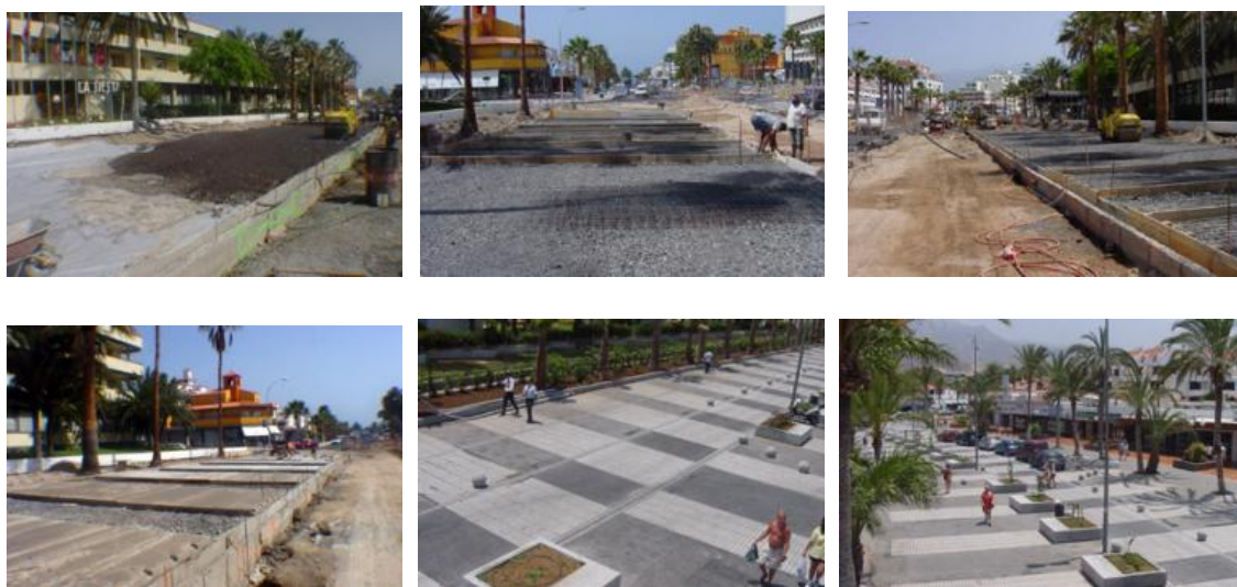
Figura 5.30: Obras del paseo marítimo (2007). ►
