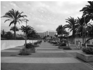
▲ Figura 5.168: Estado actual del paseo marítimo a la altura de la Playa de Troya.
