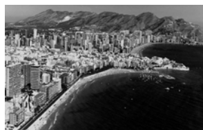
▲ Figura 1.1: Vista aérea antes de la remodelación
