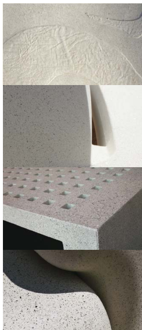
▲ Figura 5.136: Ejemplos del hormigón decapado
