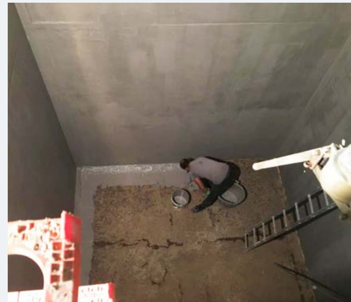
Impermeabilización del depósito de protección contraincendios del Paraninfo
