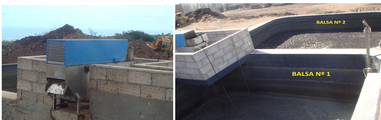
Imagen 8. Separador de purines, balsas de tratamiento de los purines
