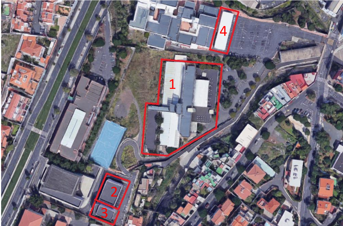
1. Edificio Principal 2. El Ramonal 3. El Ramonal exterior 4. Aulas modulares
