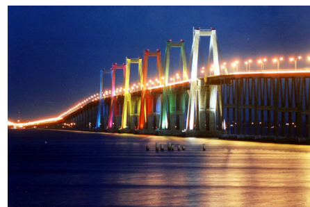
Puente Gral. Rafael Urdaneta, Maracaibo, estado Zulia
