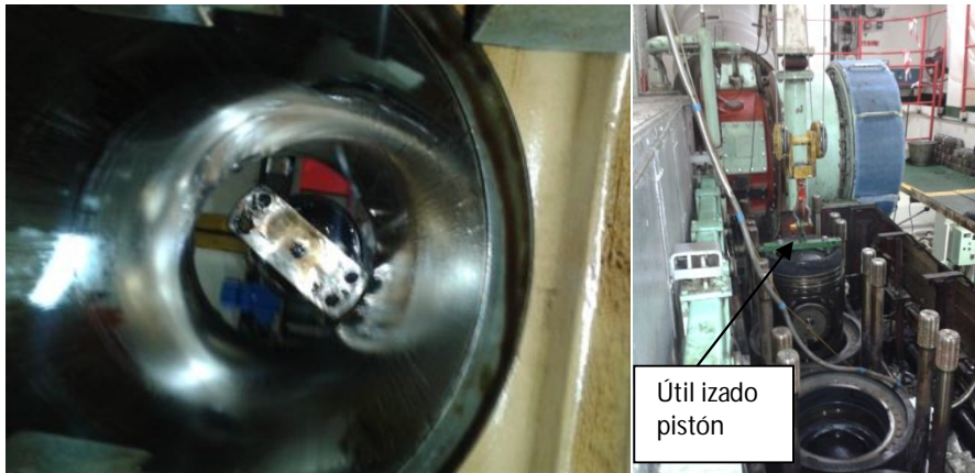
Ilustraciones 44 y 45: Extracción de los pistones. Fuente: Trabajo de campo
