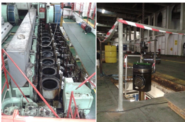
Ilustraciones 66 y 67: Extracción e izado de pistones motor principal Fuente: Trabajo de campo
