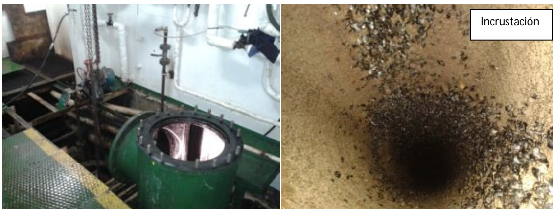
Ilustraciones 74 y 75: Filtro fondo de agua de mar y colector agua de mar.
