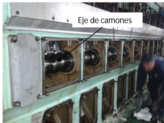
Ilustración 15: Inspección eje de camones motor principal Fuente: Trabajo de campo
