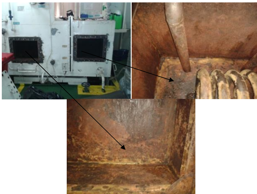
Ilustraciones 94, 95 y 96: Tanque de observaciones e interior Fuente: Trabajo de campo
