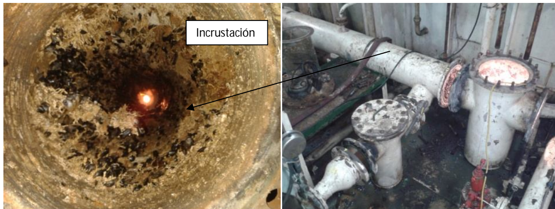
Ilustraciones 36 y 37: colector agua de mar y filtros Fuente: Trabajo de campo
