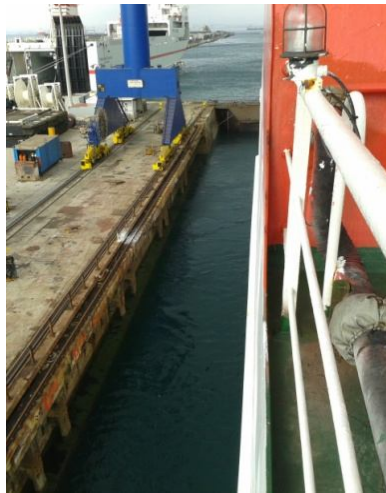
Ilustración 114: Dique seco inundado Fuente: Trabajo de campo
