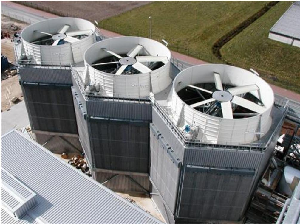
**Fig. 17** Módulo de condensadores refrigerados por aire Hexacool® [29]
