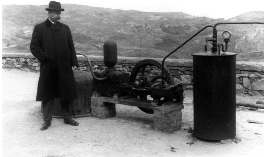
**Fig. 1** Príncipe Piero Conti en la primera instalación de generación de energía eléctrica de origen geotérmico en Larderello, Italia, en 1904. [1]
