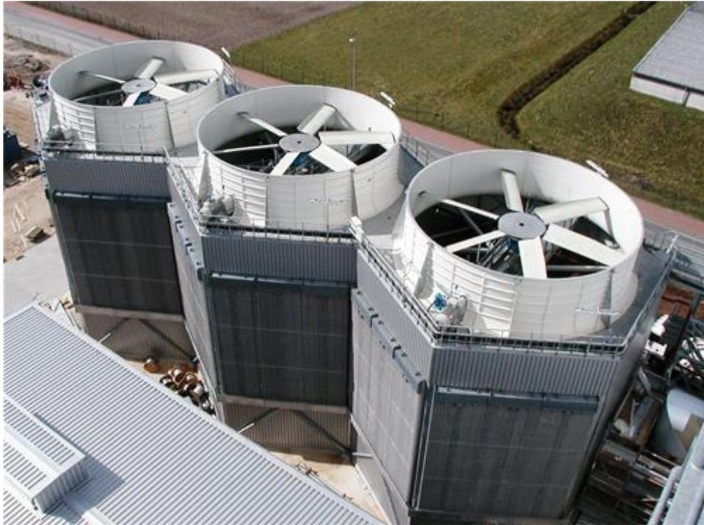
**Fig. 7** Módulo de condensadores refrigerados por aire Hexacool® [15]
