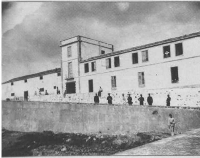
165. José V. González Bethencourt: Fachada del Hospital Militar a la calle Galcerán a finales del siglo XIX(2009).
