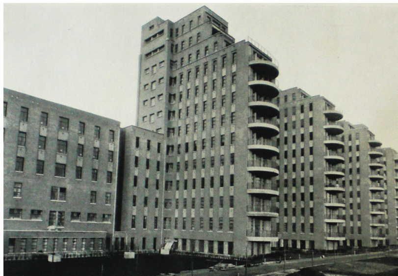
82. Bruno Moretti: Vista del Hospital Beaujon en la que se puede apreciar detalle de sus terrazas (1935).
