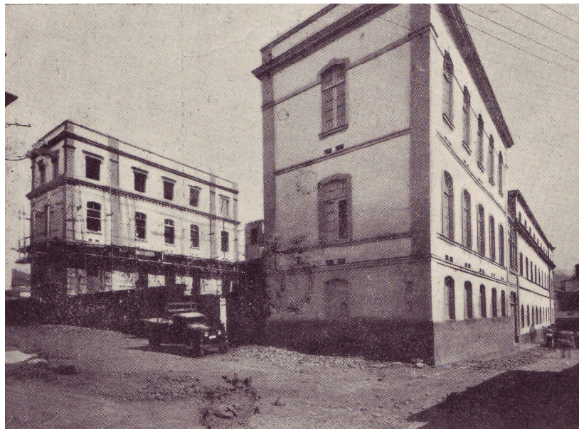
147. Anónimo: Pabellón en construcción del Hospital Civil (ca. 1929).
