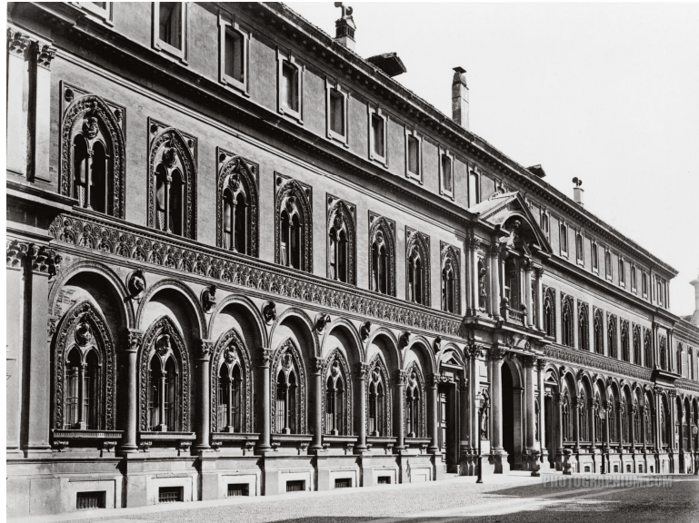
59. Anónimo: Fachada del Ospedale Maggiore en Milán construido en la década de 1460 (1860-90).
