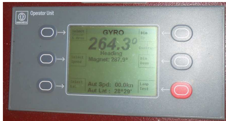
Ilustración 45. Repetidores girocompás y control de los distintos compases del buque. Fuente: Trabajo de campo
