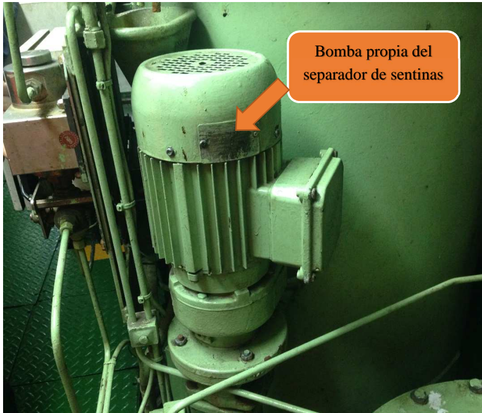
Figura 33 - Detalle de la bomba propia del separador de sentinas.
