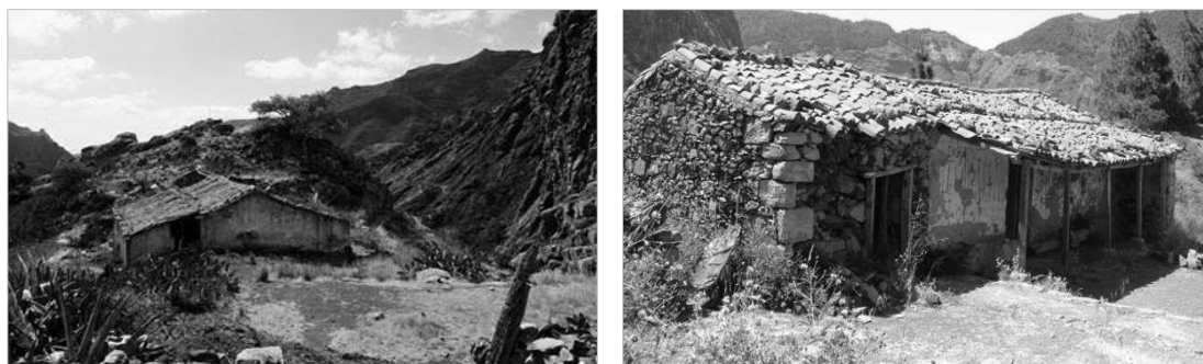
Antiguas casas de medianeros en ruinas en Benchijigua.
