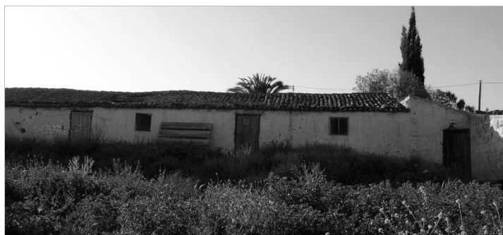
Antigua vivienda de trabajadores en Tecina (sin determinar la empresa).
