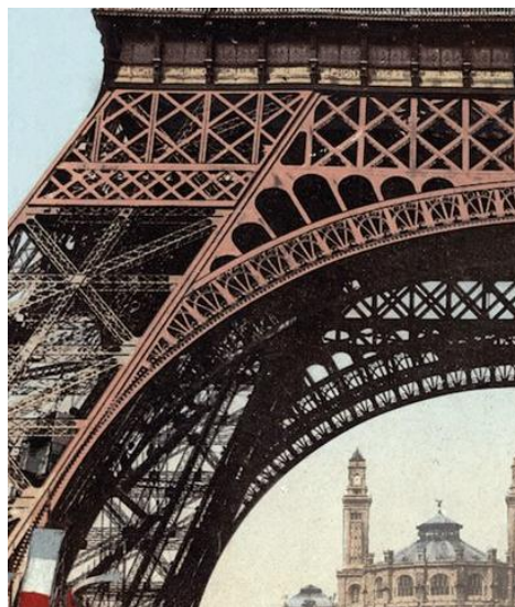
Figura 29: Estructura triangulada de la Torre Eiffel [11]
