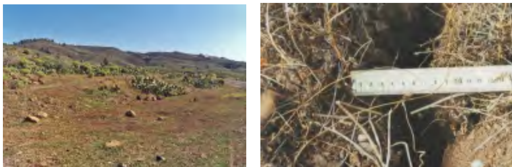
Figura 66 Vista general de la zona 52 y detalle de las grietas en período seco
