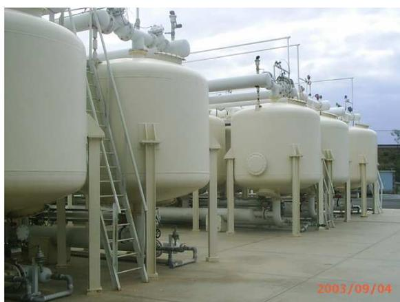
**Figura 1.3** Batería de filtros a presión del Complejo de Tratamiento de aguas depuradas del Valle de San Lorenzo.
