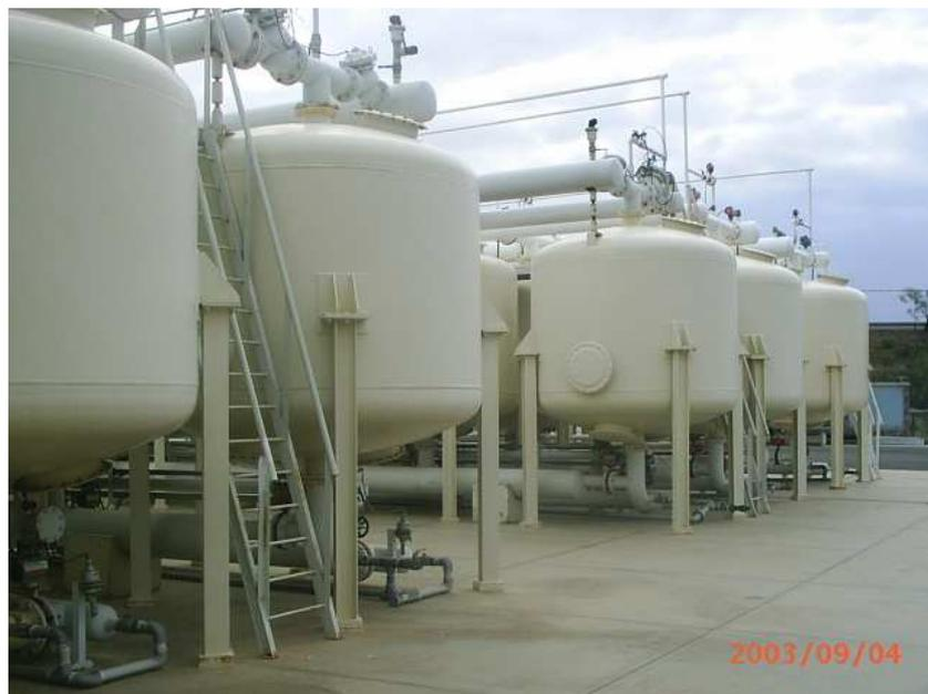
**Figura 3.2** Batería de filtros a presión deL Complejo de Tratamiento de aguas depuradas del Valle de San Lorenzo, Tenerife.
