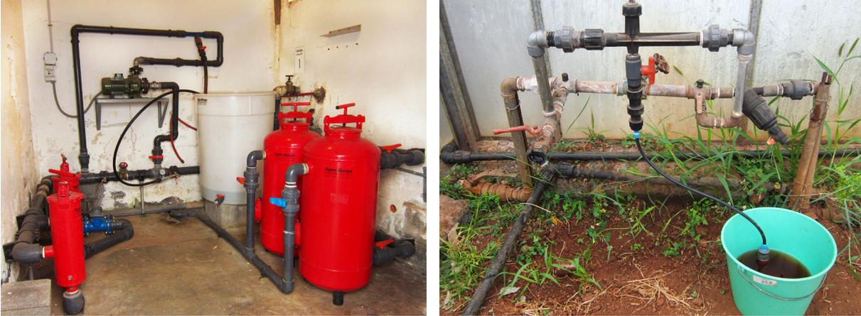
Imagen 3.6: Cabezal de riego (izquierda) y detalle del equipo tipo Venturi conectado en derivación a la tubería principal durante la fertirrigación (derecha).
