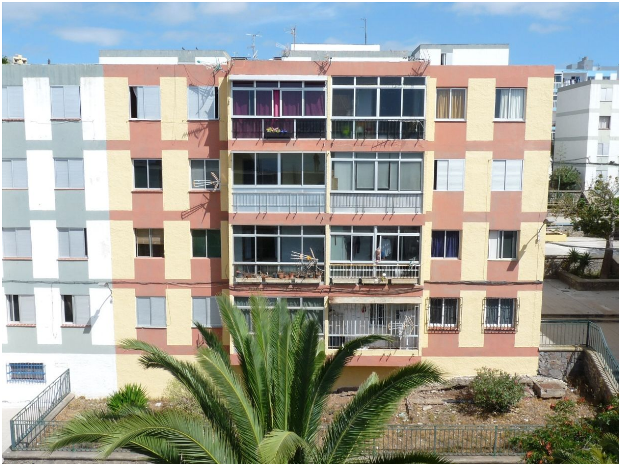
Figura 2: Fotografía de fachada trasera del Bloque 71 de El Cardonal. Fuente: Muvisa.
