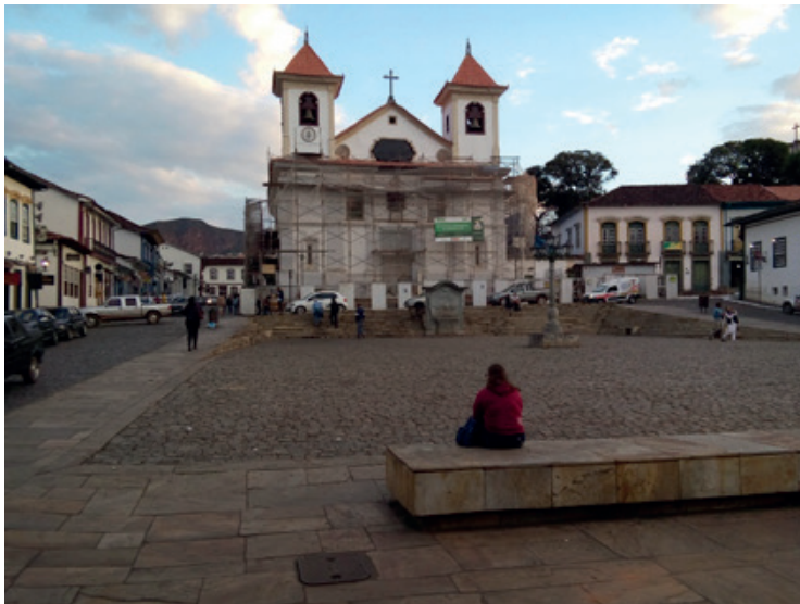
Figura 3: Praça da Sé, com igreja em reforma à época.
